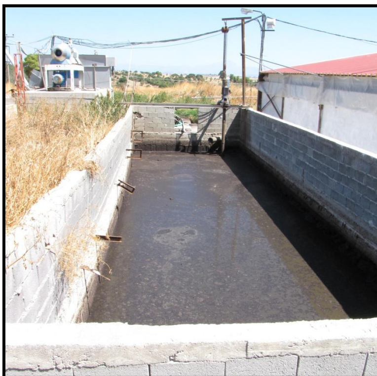
Εικόνα 1.6. Διαχωριστής και δεξαμενή διαχωρισμένων υγρών. (Πηγή: Προσωπικό αρχείο)
