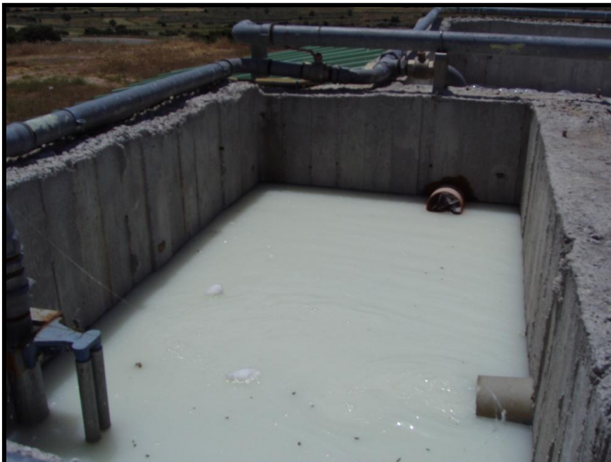
Εικόνα 1.10. Εγκατάσταση “βιολογικού καθαρισμού” του τυροκομείου - Δεξαμενή καθίζησης
