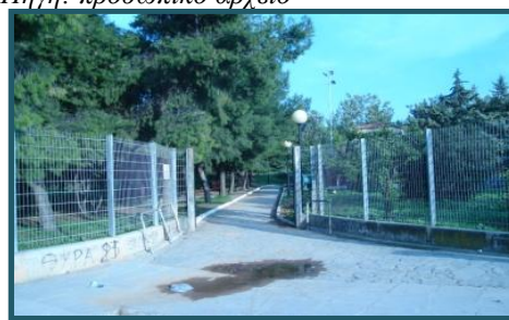
Εικόνα 7.21. Δευτερεύουσα είσοδος από το χώρο Στάθμευσης Α'.
