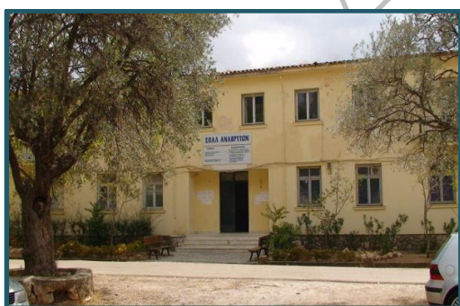
Εικόνα 7.177. Άποψη του ΤΕΕ Αναβρύτων σήμερα. Πηγή: προσωπικό αρχείο
