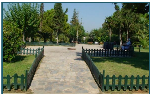
Εικόνες 7.105. Πλακόστρωση διαδρόμων με σχιστόπλακες.
