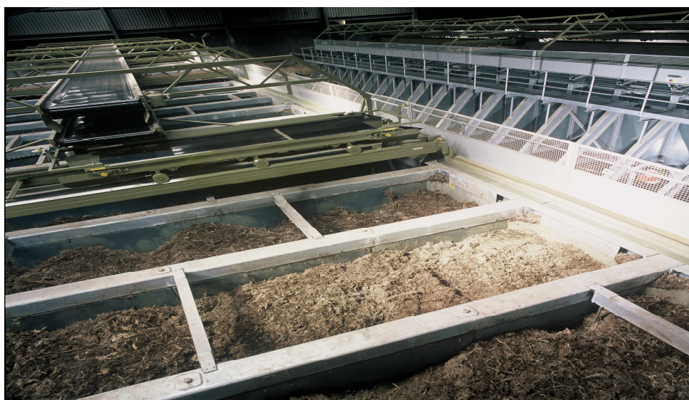
Εικόνα 1.9.4: Κλειστές δεξαμενές κομποστοποίησης
