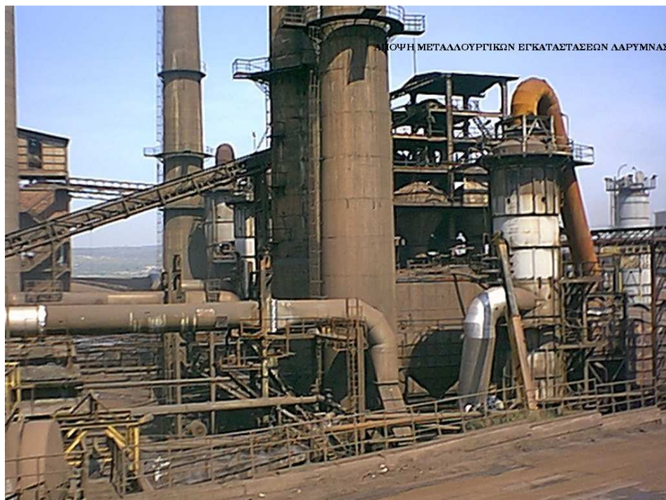
Λεπτομέρεια των μεταλλουργικών εγκαταστάσεων της Λάρυμνας (Πηγή: Λάρκο, Asterismos).
