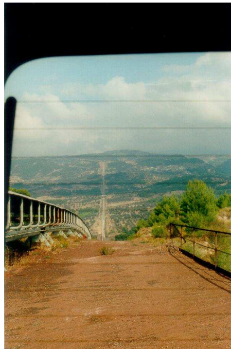
Άποψη του ταινιόδρομου μεταφοράς μεταλλεύματος (Πηγή: Λάρκο, Asterismos).
