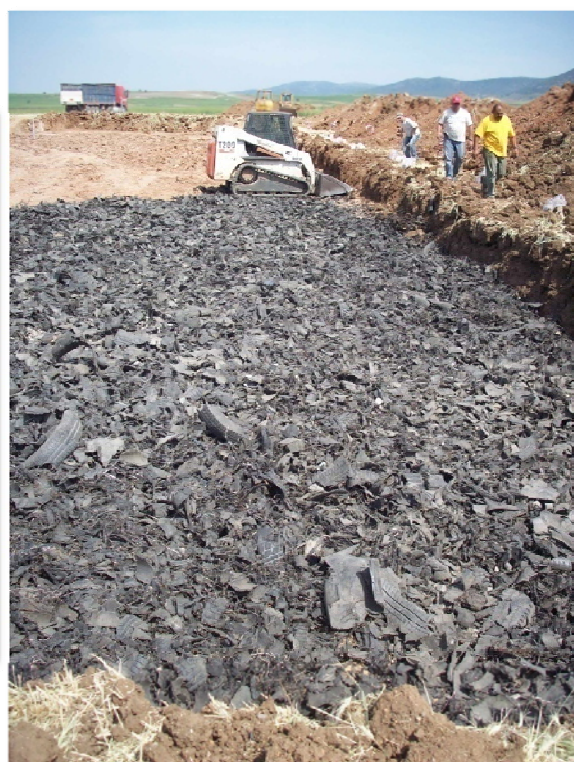
Εικόνα 7. Τοποθέτηση στρώσης των τεμαχισμένων ελαστικών.
