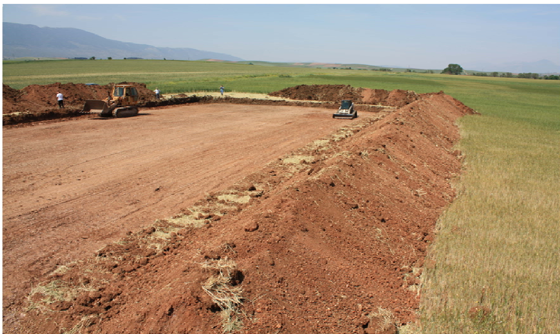
Εικόνα 4. Εκσκαφή όλης της έκτασης του πειραματικού αγρού για την τοποθέτηση στρώσης τεμαχισμένων ελαστικών σε βάθος 80-100cm.
