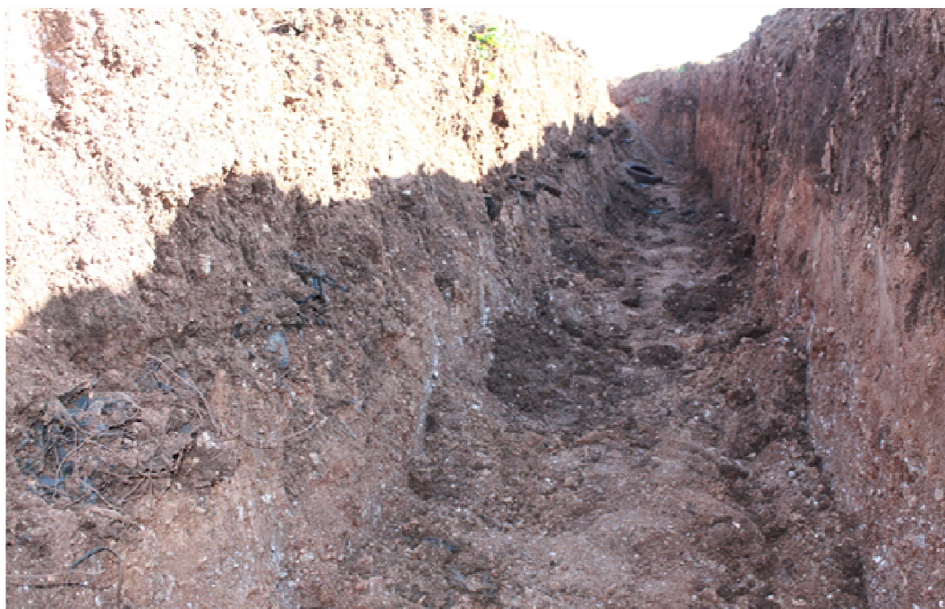
Εικόνα 10. Διάνοιξη ορύγματος βάθους 2 m για την πραγματοποίηση της 2 ης δειγματοληψίας εδάφους κάτω από τη στρώση των ελαστικών.
