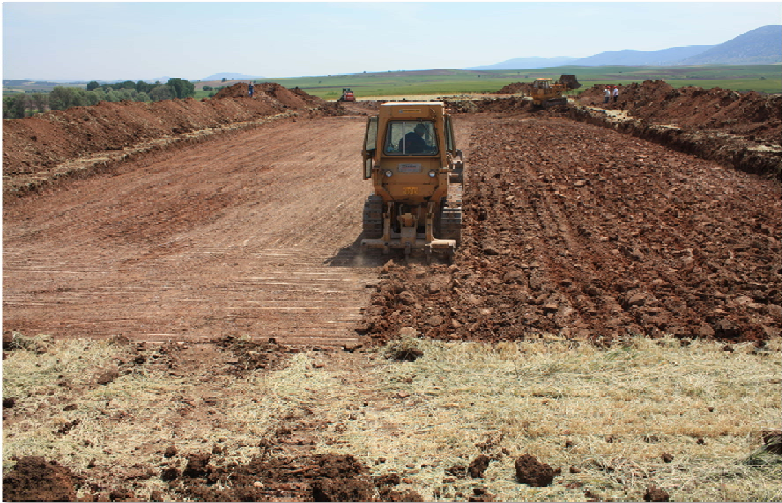
Εικόνα 5. Κατεργασία εδάφους για την αποφυγή τυχόν συμπίεσης που μπορεί να προκλήθηκε από τα μηχανήματα εκσκαφής.
