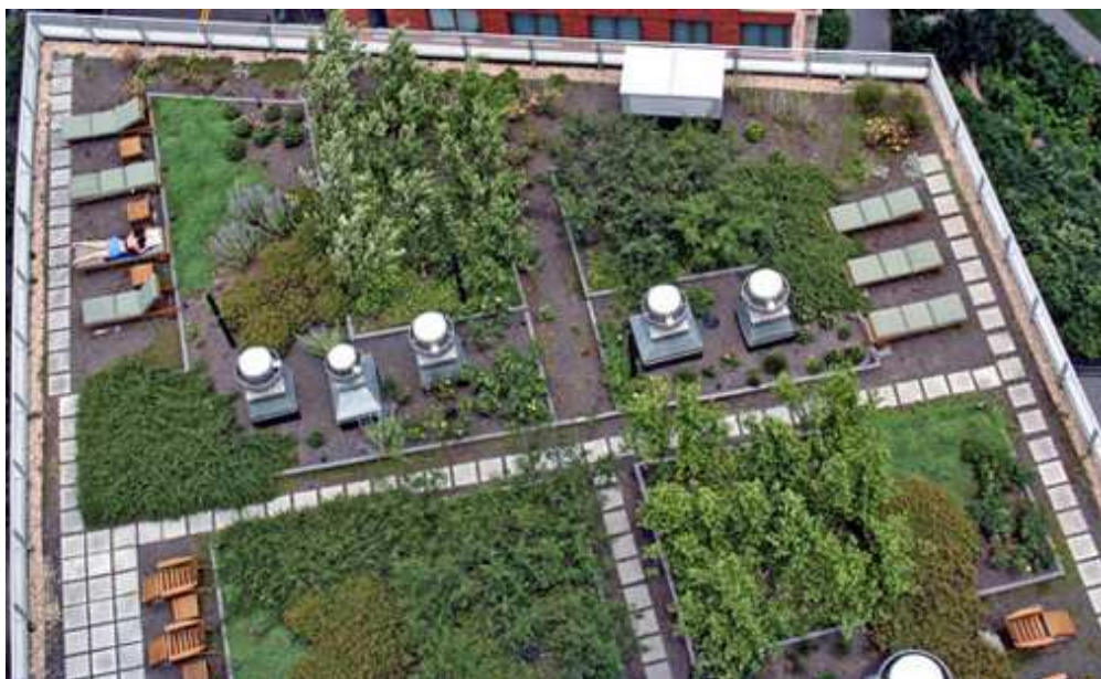
Εικόνα 2. Σύστημα εντατικού τύπου σε οροφή κτιρίου. (Πηγή: http://www.canpages.ca )
