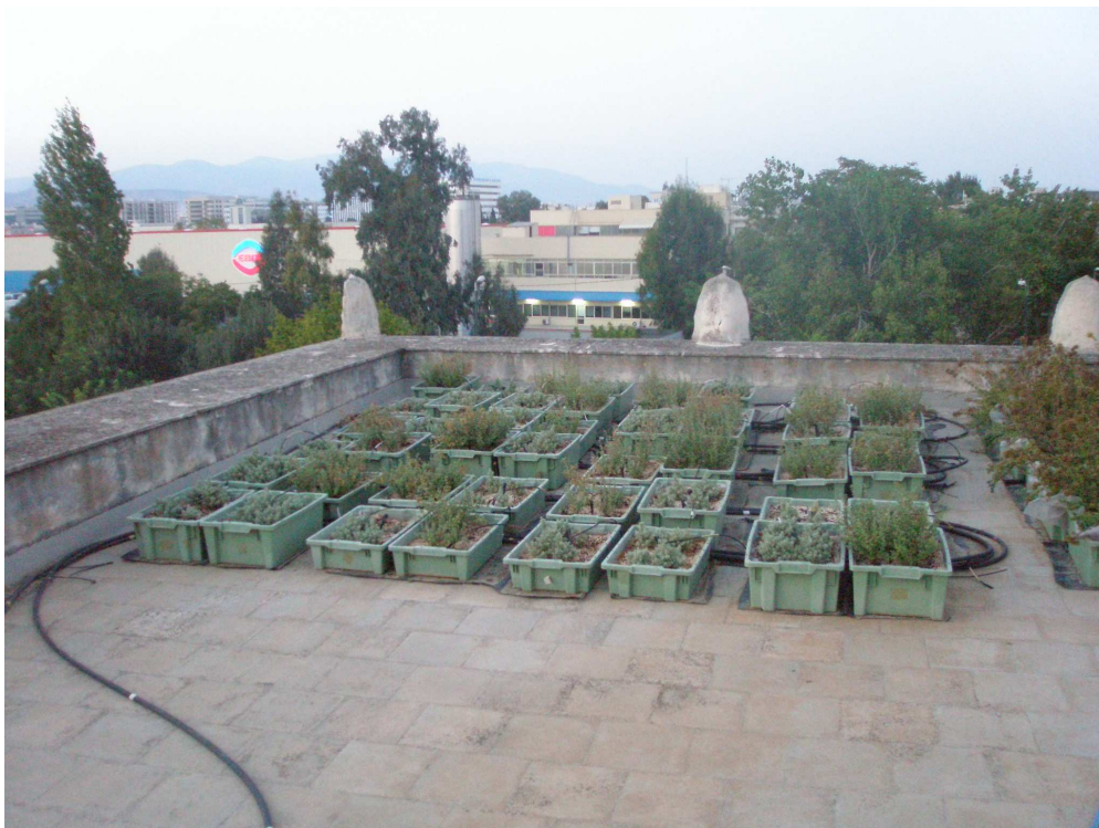
Εικόνα 9. Διάταξη κιβωτίων στο δώμα του Κεντρικού Κτιρίου του Γ.Π.Α.
