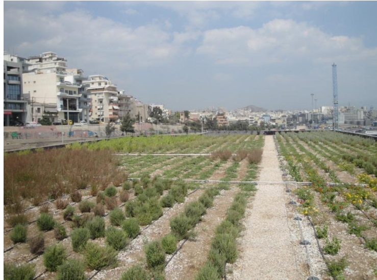
Εικόνα 1. Εκτατικού τύπου φυτεμένο δώμα στον ΟΛΠ, στο Ν. Ικόνιο ( www.prasinistegi.gr )
