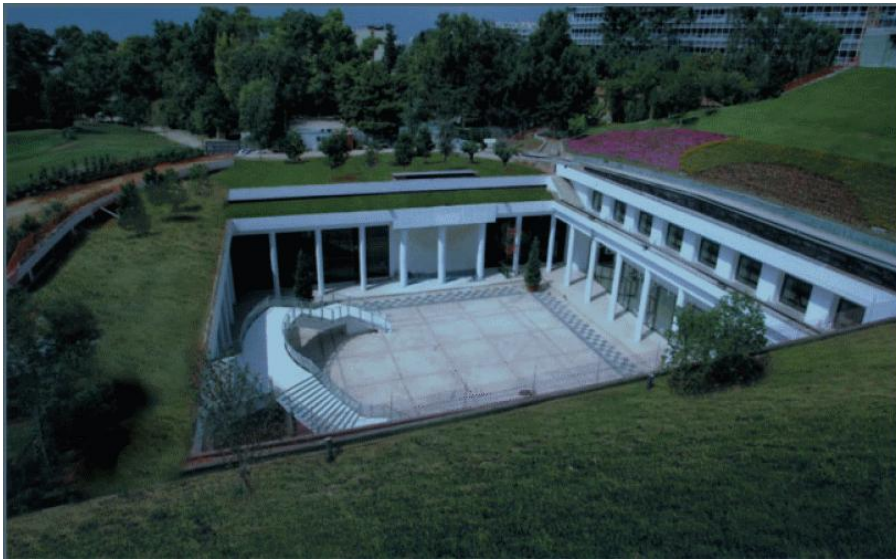
Εικόνα 3. Εντατικού τύπου φυτεμένο δώμα στο Μέγαρο Μουσικής Αθηνών ( www.liveinspector.gr )
