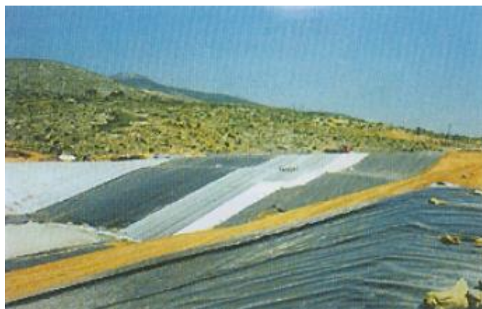
Εικόνα 10. Τοποθέτηση γεωσυνθετικών στα πρανή της Φάσης I
