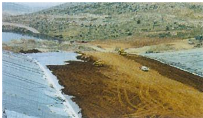
Εικόνα 9. Κατασκευή άνω αργιλικού φραγμού στον πυθμένα της Φάσης I
