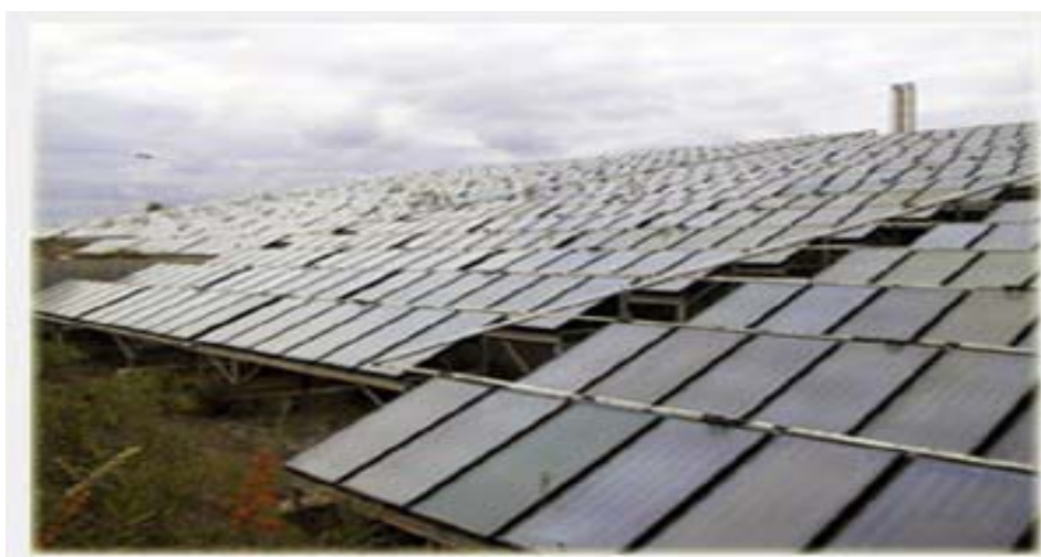
Σχήμα 1.14: Πεδίο Ηλιακών Συλλεκτών για χρήση ηλιακής θέρμανσης –Ψύξης στο εργοστάσιο καλλυντικών του Σαράντη στα Οινόφυτα. Παγκόσμια προτυπία .
