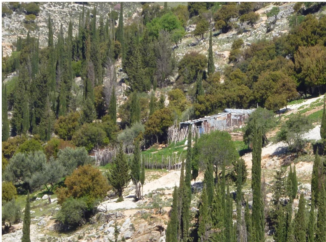
Εικόνα 6.8: «Κτηνοτροφικό κτίσμα στην περιοχή Διλινάτα»
