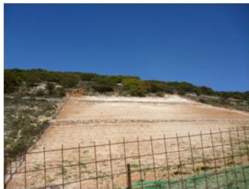
Εικόνα 4.17: Κατασκευή νέων αναβαθμίδων
