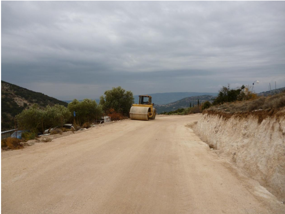
Εικόνα 6.2.: «εργασίες διάνοιξης δρόμου στην περιοχή Μονηλάτη-Διλινάτα»
