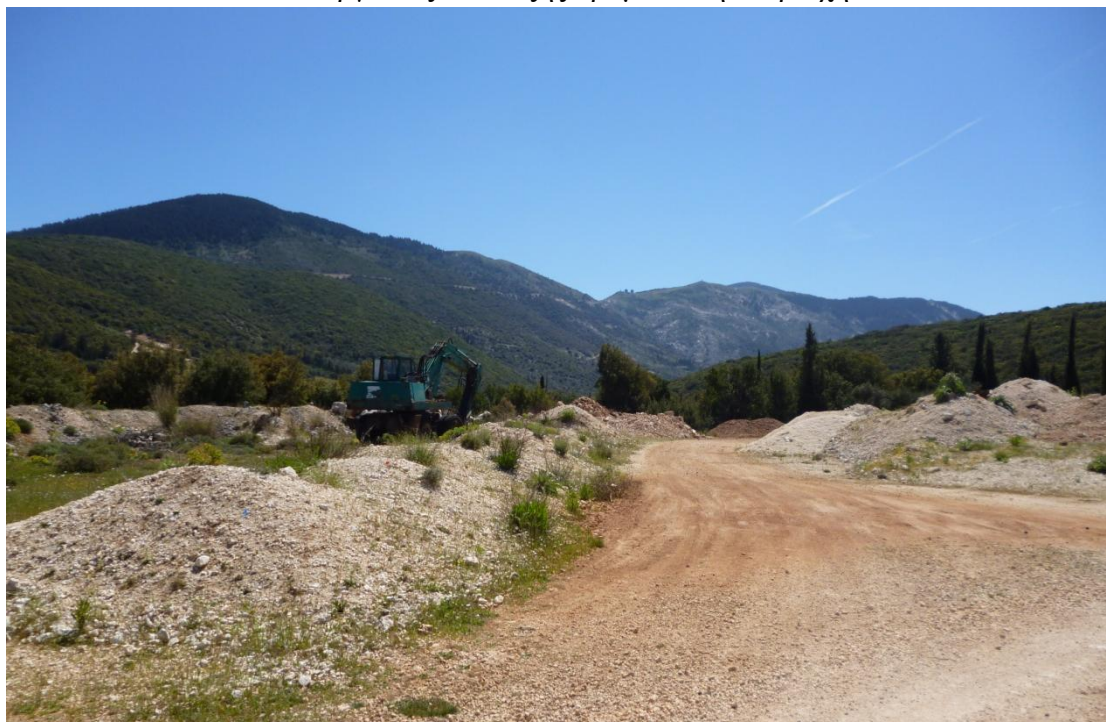
Εικόνα 6.1: «εργασίες διάνοιξης δρόμου στην περιοχή Λανού»
