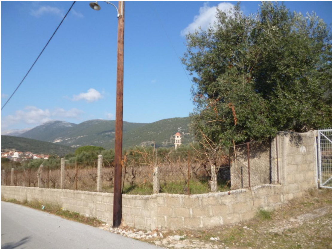
Εικόνα 6.5: «περίφραξη με τσιμεντένια μάντρα αμπελώνα στην περιοχή Μικάτων»
