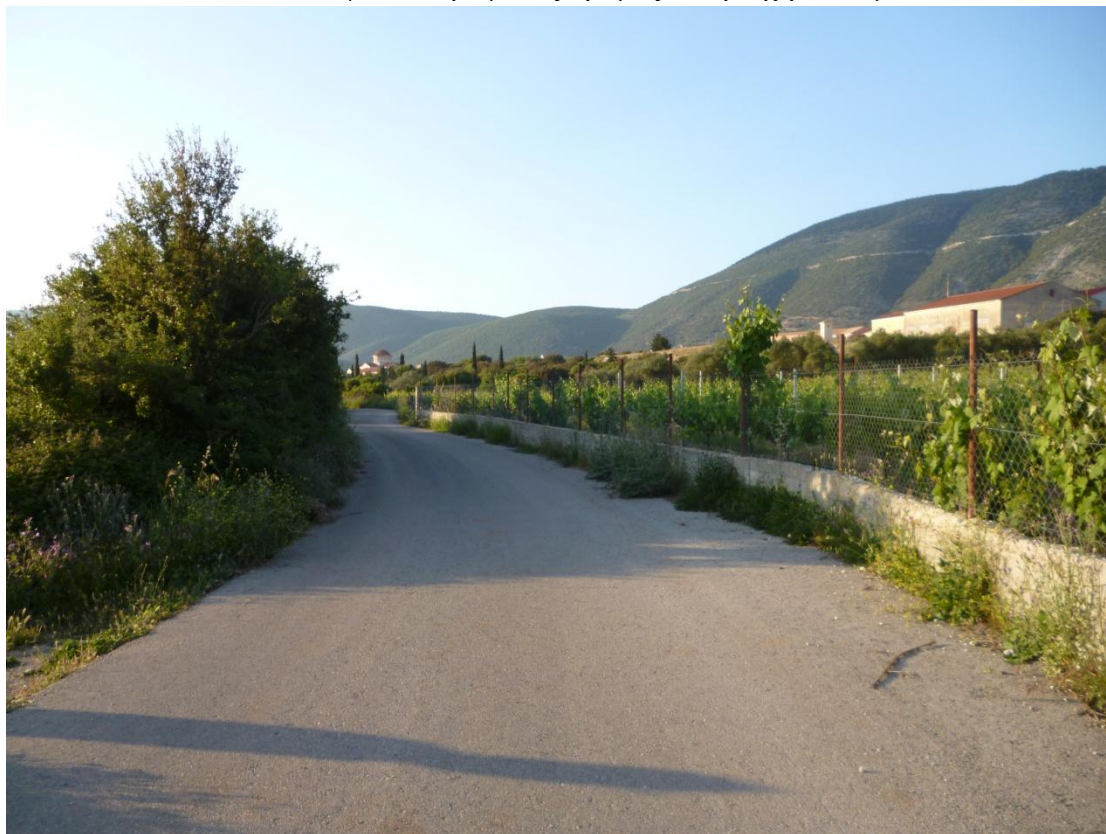
Εικόνα4.5: «Ασφαλτοστρωμένος δρόμος» Περιοχή: Κ. Ομαλών»
