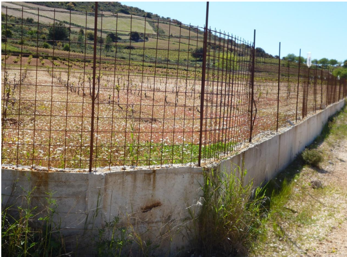
Εικόνα 6.3: «Περίφραξη με τσιμεντένια μάντρα αμπελώνα στην περιοχή Λακομάτια»
