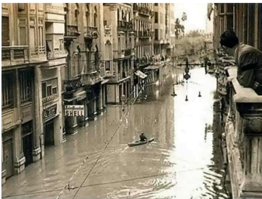
Εικόνα 7: Εικόνα από την καταστροφική πλημμύρα στη Βαλένθια το 1957. (Πηγή: http://www.metropolismag.com/pov/20120630/valencias-green-river )
