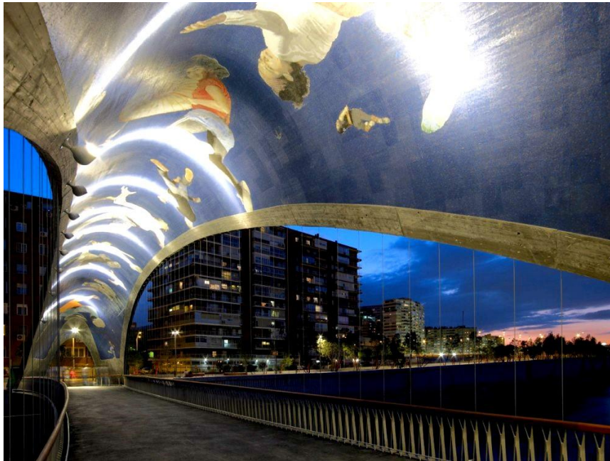
Εικόνα 15: Ο φωτισμός και το μωσαϊκό στο εσωτερικό μέρος του θόλου της γέφυρας. (Πηγή: http://setowsky.blogspot.gr/2011/02/en-corto-madrid-de-mis-amores.html )
