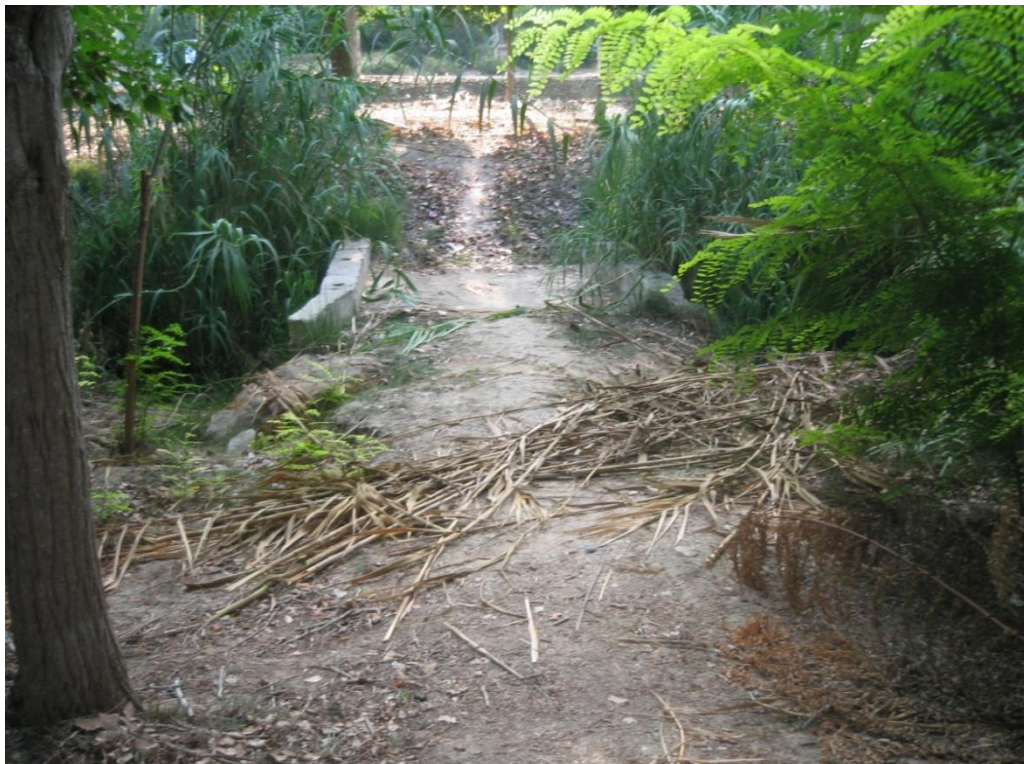
Θέση 8. Υφιστάμενη γέφυρα «Αργάκι του Κτήματος». (Πηγή: προσωπικό αρχείο)
