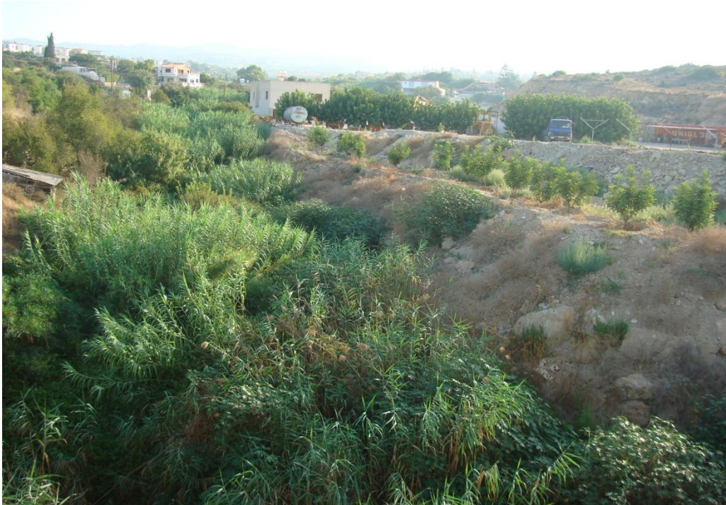
Θέση 3. Πανοραμική άποψη της κοίτης «Αργακι της Μαρούς». Στα αριστερά φαίνεται το αυθαίρετο μπάζωμα. (Πηγή: προσωπικό αρχείο)
