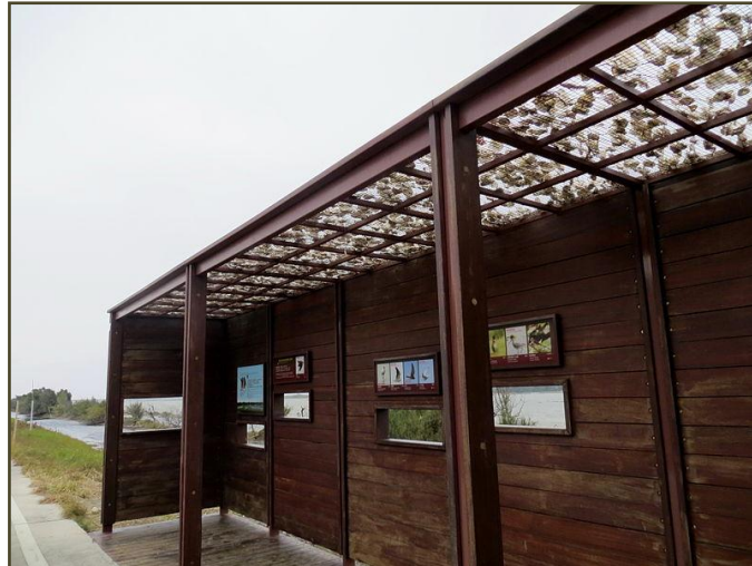
Εικόνα 123: Τοιχίο θέασης με ανοίγματα σε διαφορετικά ύψη, στέγαστρο και ενημερωτικούς πίνακες για τα πουλιά.
