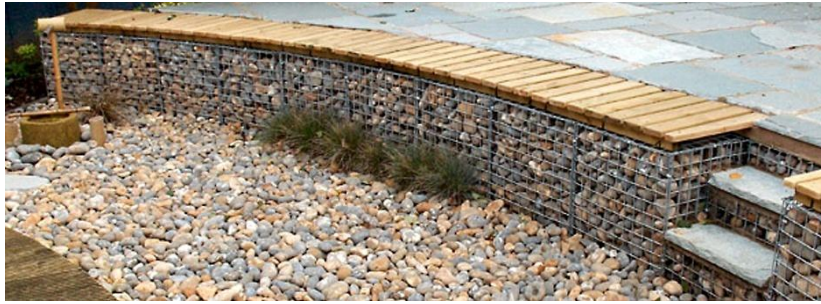
Εικόνα 140: Ειδικά διαμορφωμένο καθιστικό από συρματοκιβώτια και ξύλο.
