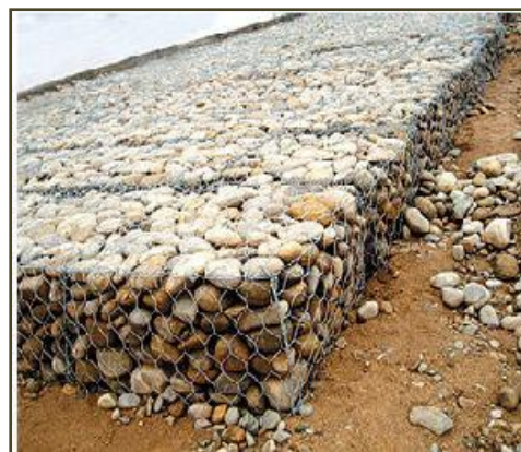
Εικόνα 101: Συρματοκιβώτια με πέτρες.
