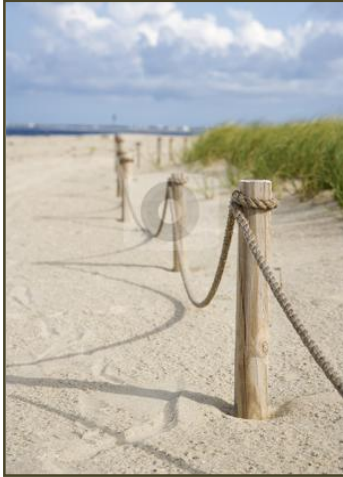
Εικόνα 97: Περίφραξη με ξύλινους πασσάλους και σχοινί.
