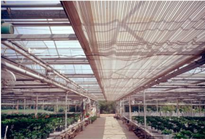
Εικόνα 3: Χρήση θερμοκουρτίνας σε θερμοκήπιο.
