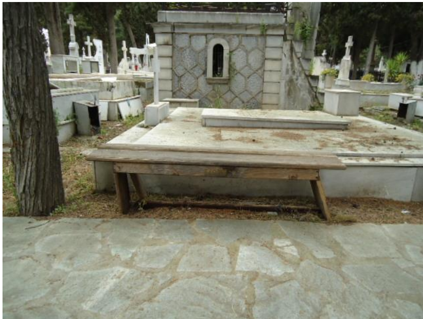
Εικ.90 Άποψη από τα κατεστραμμένα παγκάκια (πηγή: προσωπικό αρχείο)
