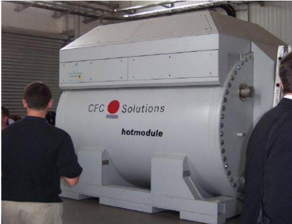
Η πρώτη παγκοσμίως κυψέλη καυσίμου τύπου MCFC για βιοαέριο, που λειτουργεί στη Γερμανία (RUTZ, 2007)( εικόνα 17)
