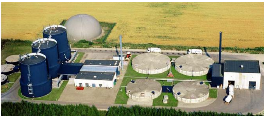
Εικόνα μιας εγκατάστασης συγχώνευσης από τη Δανία (LEMVIG BIOGAS)( εικόνα 10)
