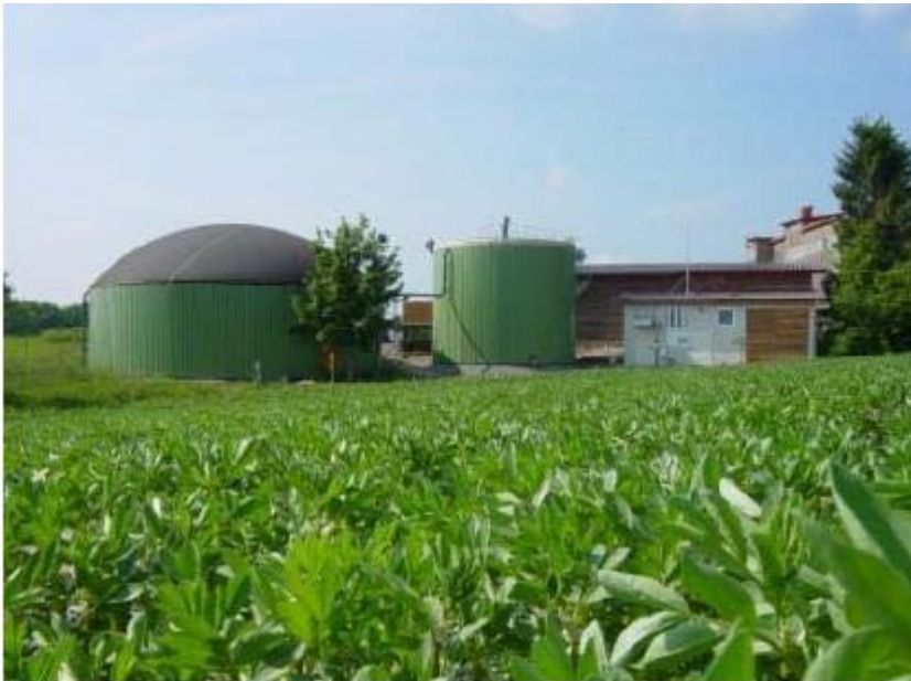
Εγκατάσταση βιοαερίου στη Γερμανία, που επεξεργάζεται κοπριάς από χοίρους, πουλερικά και σωρούς χόρτων (KRIEG AND FISHER, 2008)( εικόνα 9)
