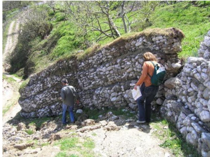
Φωτογραφίες 6.27, 6.28, 6.29 & 6.30: Καταστροφή του οδικού δικτύου εντός του οικισμού, καθώς και των συρματοκιβωτίων, τα οποία είχαν τοποθετηθεί από το Δασαρχείο για την ... ανάσχεση των κατολισθητικών φαινομένων, επιφορτίζοντας όμως περαιτέρω την ήδη ασταθή ισορροπία του πρανούς (2010).
