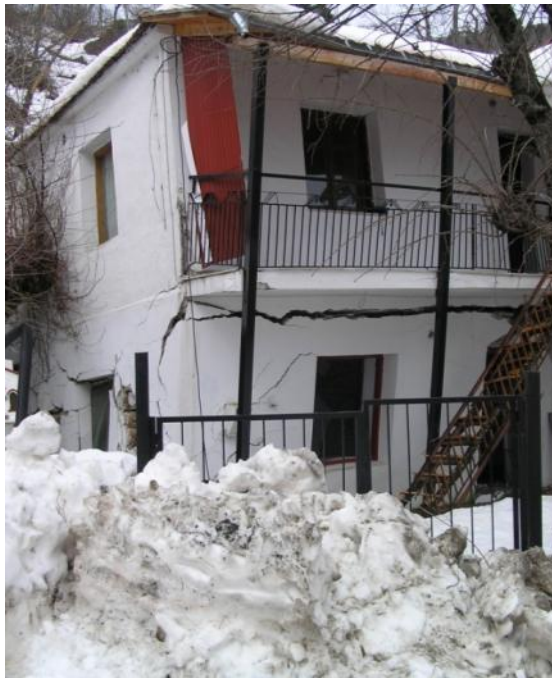
Φωτογραφία 6.22α & β: Ολοσχερής καταστροφή οικίας. Το χαρακτηριστικό της περίπτωσης αυτής είναι ότι δείχνει την συνεχή και ταχεία εξέλιξη του φαινομένου, αφού στην 1η περίπτωση το οίκημα έχει φωτογραφηθεί στις 15 Μαρτίου 2010 και στην 2η στις 5 Απριλίου 2010, δηλαδή σε διάστημα 20 ημερών (2010).
