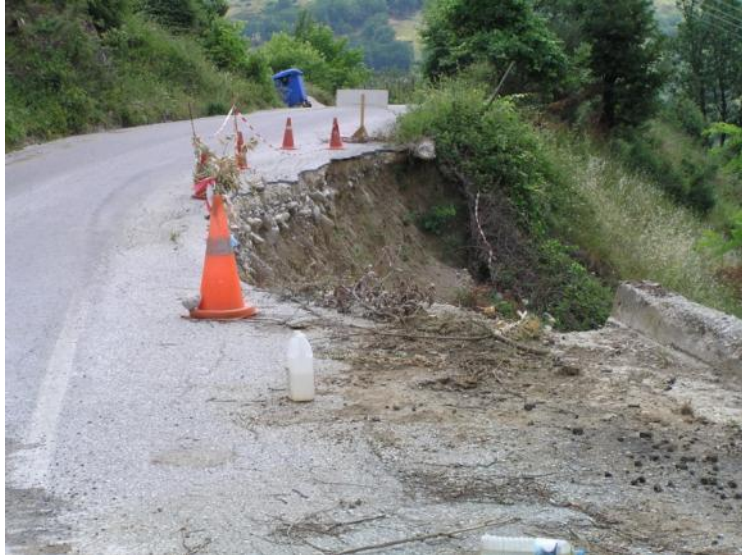
Φωτογραφία 6.43: Τμήμα της επαρχιακής οδού, η οποία οδηγεί στον κεντρικό συνοικισμό, ημικατεστραμμένος από κατολισθήσεις (2012).
