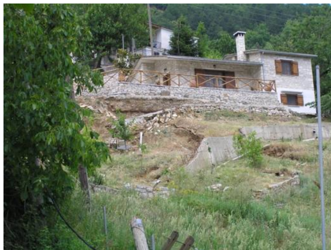
Φωτογραφία 6.44: Κατολίσθηση – κατάπτωση εξαιτίας της βαρύτητας στα «ασφαλή» αντερείσματα του Ροπωτού (2012).
