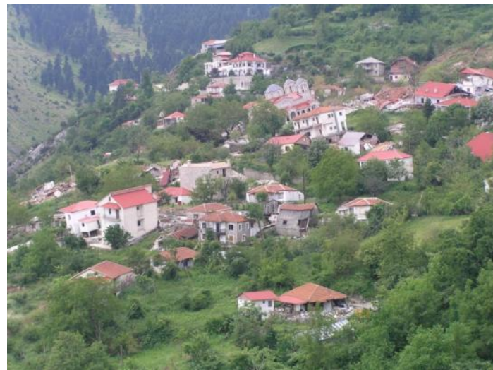
Φωτογραφία 6.35: Οι καταστροφές της κατολίσθησης (2012).
