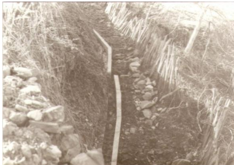
Φωτογραφία 6.2: Μετατόπιση 15 εκατοστών του υδραύλακα λόγω της ώθησης των κατολισθαινόντων σχηματισμών του φλύσχη (Κούκης, 1979).
