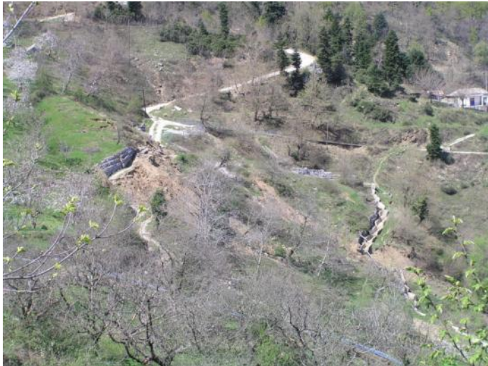
Φωτογραφίες 6.27, 6.28, 6.29 & 6.30: Καταστροφή του οδικού δικτύου εντός του οικισμού, καθώς και των συρματοκιβωτίων, τα οποία είχαν τοποθετηθεί από το Δασαρχείο για την ... ανάσχεση των κατολισθητικών φαινομένων, επιφορτίζοντας όμως περαιτέρω την ήδη ασταθή ισορροπία του πρανούς (2010).
