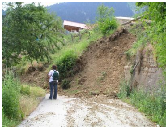
Φωτογραφίες 6.39 & 6.40: Καταστροφή του οδικού δικτύου, η οποία έκανε την πρόσβαση στις άθικτες οικίες του νότιου αντερείσματος αδύνατη.
