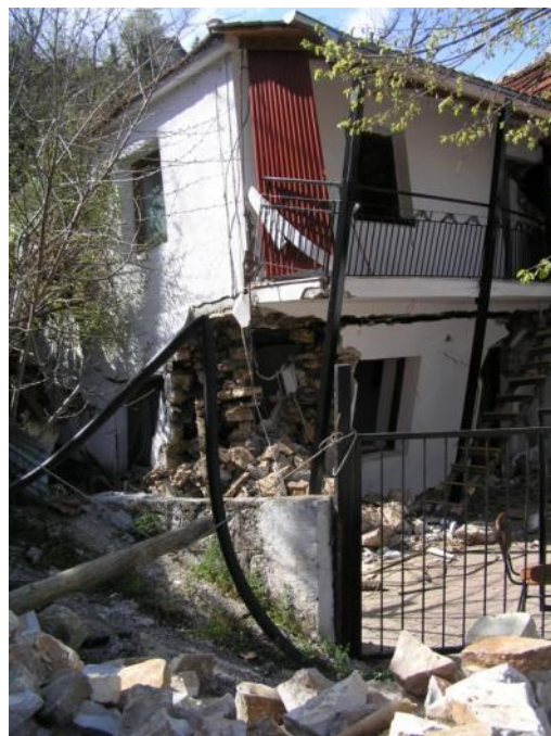
Φωτογραφία 6.22α & β: Ολοσχερής καταστροφή οικίας. Το χαρακτηριστικό της περίπτωσης αυτής είναι ότι δείχνει την συνεχή και ταχεία εξέλιξη του φαινομένου, αφού στην 1η περίπτωση το οίκημα έχει φωτογραφηθεί στις 15 Μαρτίου 2010 και στην 2η στις 5 Απριλίου 2010, δηλαδή σε διάστημα 20 ημερών (2010).
