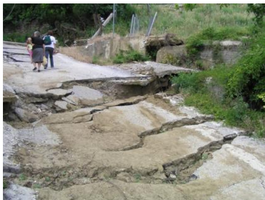
Φωτογραφίες 6.39 & 6.40: Καταστροφή του οδικού δικτύου, η οποία έκανε την πρόσβαση στις άθικτες οικίες του νότιου αντερείσματος αδύνατη.
