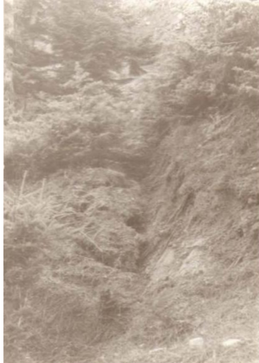
Φωτογραφία 6.1: Τμήμα της τοξοειδούς και επί μήκους 300 μέτρων θραύσεως στην κεφαλή της κατολίσθησης. Στη θέση αυτή είναι πιθανή η ενεργοποίηση και των ανωτέρων οριζόντων του υγιούς φλύσχη. Χαρακτηριστικό είναι το "τέντωμα" των ριζών των δένδρων, κατά μήκος της επιφάνειας ολίσθησης (Κούκης, 1979).
