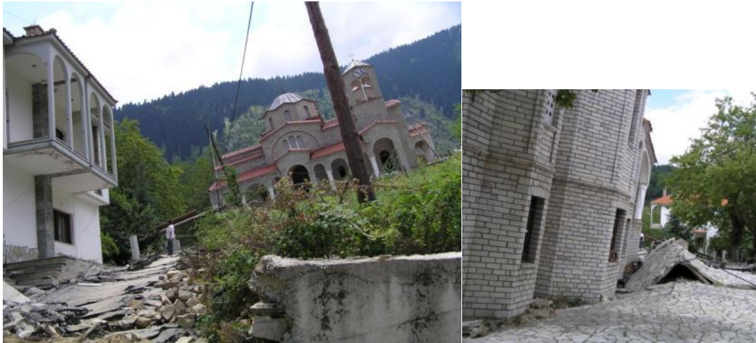
Φωτογραφία 6.36α & β: Η εκκλησία του οικισμού, η οποία δεν έπαθε ζημιές ως κτίσμα, αλλά μετατοπίστηκε όλη μαζί (2012).
