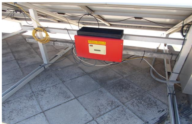
Εικόνα 21 Μετατροπέας SMA sunny boy 2,5 kW
