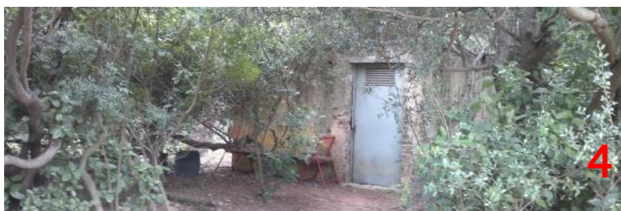
Εικόνα 38: Το πρώην αντλιοστάσιο ΝΔ του κτήματος, (2014) (προσωπικό αρχείο) (Θέση 4, Σχέδιο 1).
