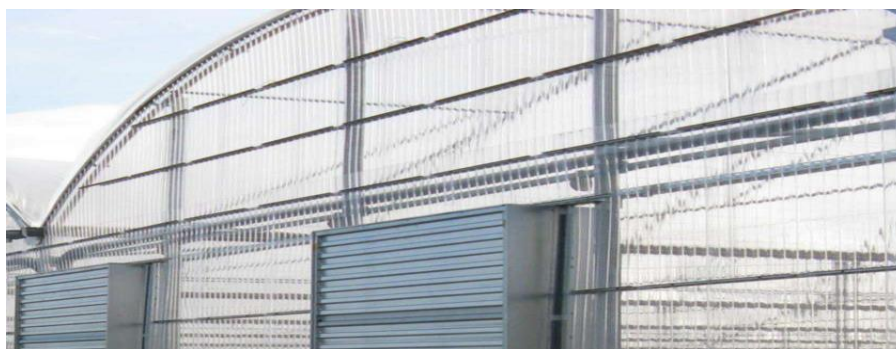
Εικόνα 26: Πλευρική Κάλυψη Θερμοκηπίου με πολυκαρβονικά (polycarbonate) φύλλα διάφανα ειδικού προφίλ
