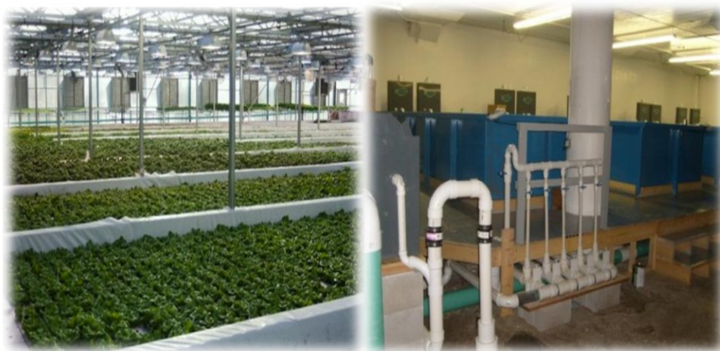
Εικόνα 9: Εγκατάσταση ενυδρείοπονικής καλλιέργειας -αριστερά υποσύστημα υδροπονίας και δεξιά υποσύστημα υδατοκαλλιέργειας
