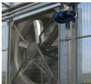
Εικόνα 29: Σύστημα Δροσίμου- Ανεμιστήρες δροσίμου
