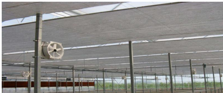
Εικόνα 27: Σύστημα Θερμοκουρτίνας του Θερμοκηπίου
