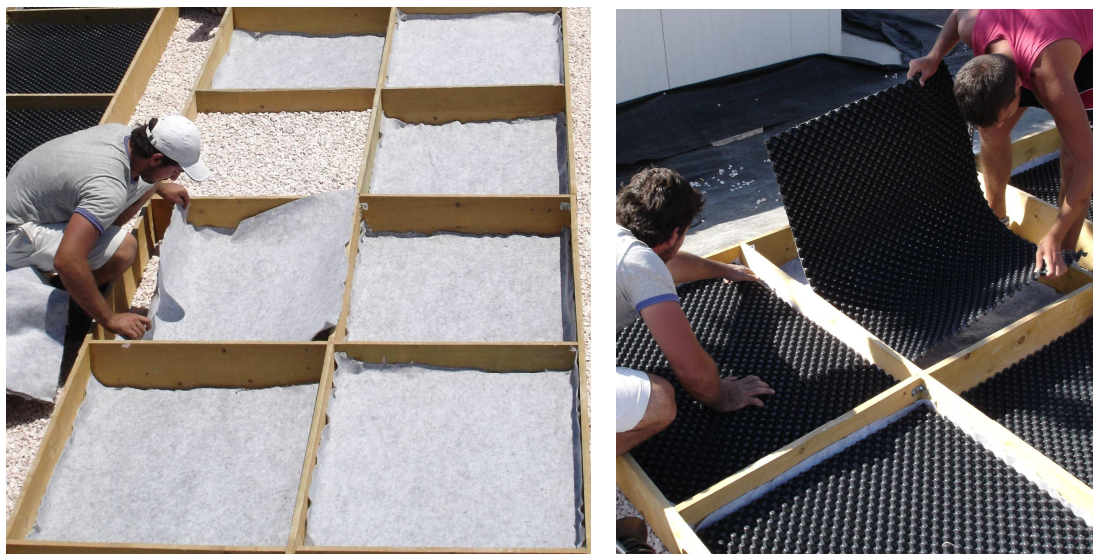
Εικόνες 3.7-3.8. Τοποθέτηση του υφάσματος προστασίας και της αποστραγγιστικής διάστρωσης εντός των πειραματικών τεμαχίων.
