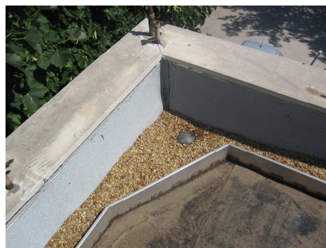
Εικόνες 5.2-5.4. Περιμετρικό αποστραγγιστικό κανάλι του δώματος με ψηφίδα.
