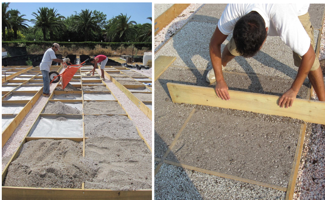
Εικόνες 3.13-3.14. Πλήρωση των πειραματικών τεμαχίων με τα υπό μελέτη υποστρώματα και τελική ισοπέδωσή τους.
