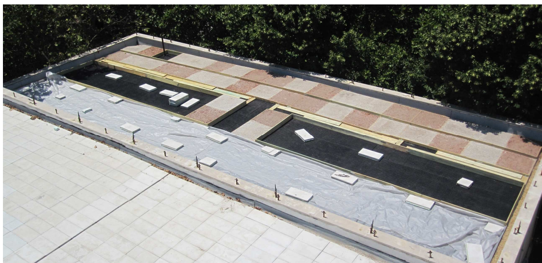
Εικόνες 5.8-5.10. Πλήρωση των πειραματικών τεμαχίων με τα δύο υπό μελέτη υποστρώματα.
