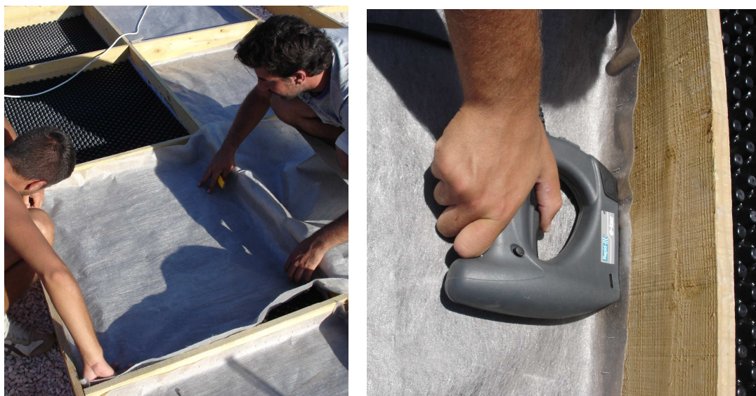
Εικόνες 3.9-3.10. Τοποθέτηση του γεωφάσματος πάνω από την αποστραγγιστική διάστρωση και πάκτωση αυτού στις ξύλινες πλευρικές σανίδες.
