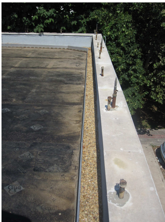
Εικόνες 5.2-5.4. Περιμετρικό αποστραγγιστικό κανάλι του δώματος με ψηφίδα.
