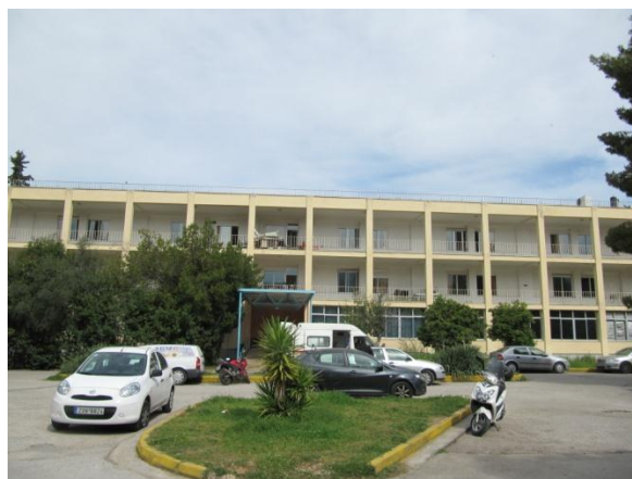
Εικόνα 3.4.26: Κτίριο Μέγα Λαϊκό (Φωτογραφία Νο 59)
