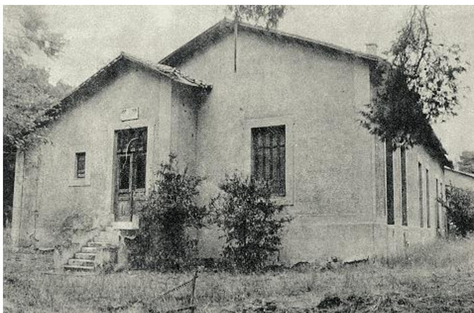
Εικόνα 2.1.7: Φθισιατρείον «Σωτηρία». Το περίπτερο «Τριανταφυλλάκι» προ της πρόσφατης επισκευής του. Κατασκευάστηκε το 1911-12 με σχέδια του αρχιτέκτονα Α.Μπαλάνου (φωτογραφία 1984, Κ. Κατής, ο.π.), (Πηγή: Ερευνητικό πρόγραμμα Α' φάση Γουδί – Μάιος 1998)
