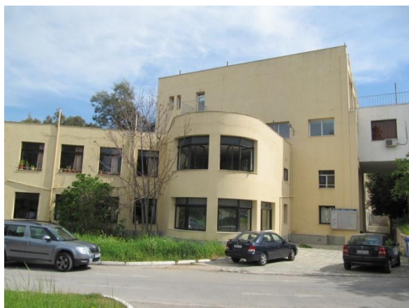
Εικόνα 3.4.25: Κτίριο Μέγα Λαϊκό (Φωτογραφία Νο 56)
