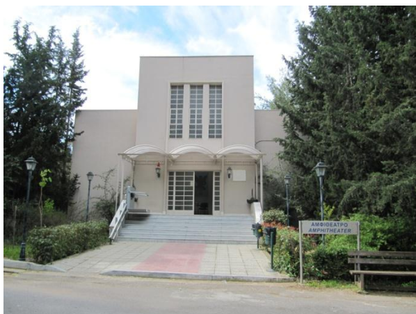
Εικόνα 3.4.27: Αμφιθέατρο νοσοκομείου «Η Σωτηρία» (No 68)
