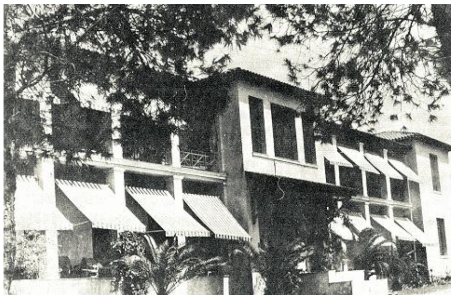
Εικόνα 2.1.9: Φθισιατρείον «Σωτηρία». Το περίπτερο «Σπηλιοπούλειο, κατασκευής του 1914, (φωτογραφία 1937, Κ. Κατής, ο.π.), (Πηγή: Ερευνητικό πρόγραμμα Α' φάση Γουδί – Μάιος 1998)
