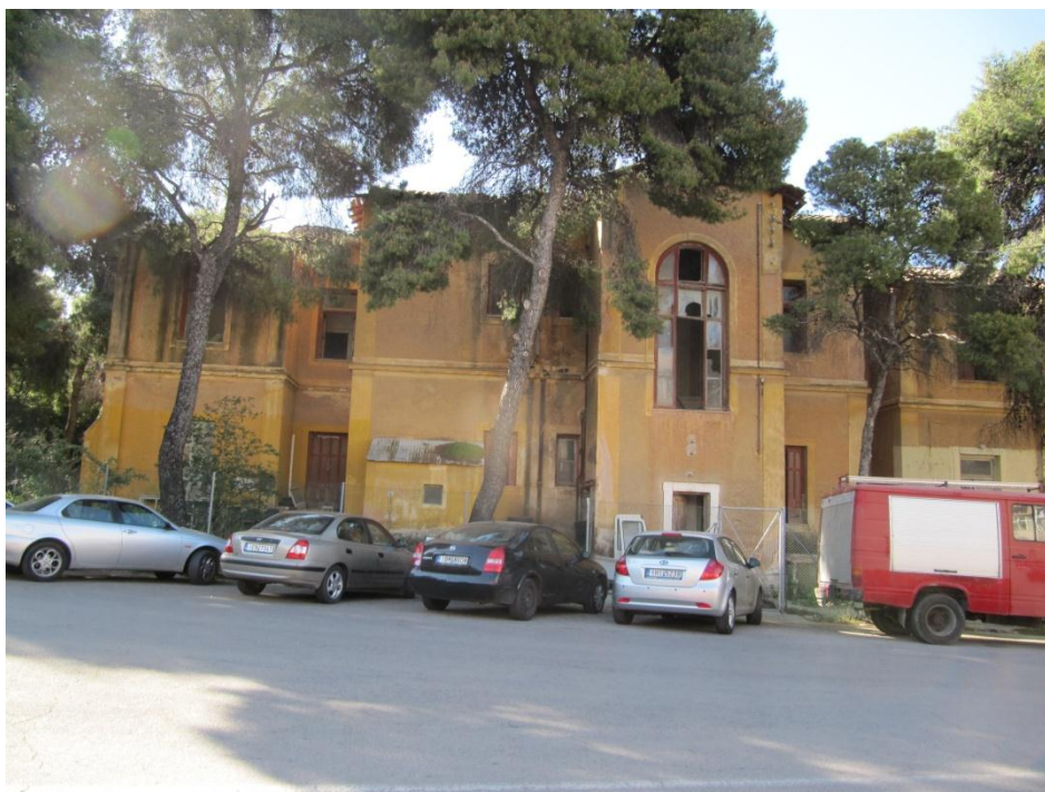
Εικόνα 3.4.12: Περίπτερο «Αμπέτσι» (φωτογραφία Νο 16)
