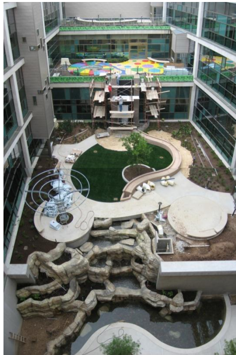
Εικόνα 1.5.1: Αυλή, Dell Children's Medical Center (Πηγή: http://www.austinchronicle.com/blogs/news/2007-06-27/496674/ )
