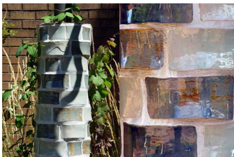
Εικόνα 1.6.29: Λεπτομέρεια της κολώνας του περιπτέρου (Πηγή: http://www.rhizaaplusd.com/installation/shadow-pavilion/ )
