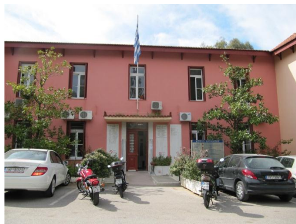
Εικόνα 3.4.28: Κτίριο Διοίκησης του νοσοκομείου «Η Σωτηρία» (No 72)
