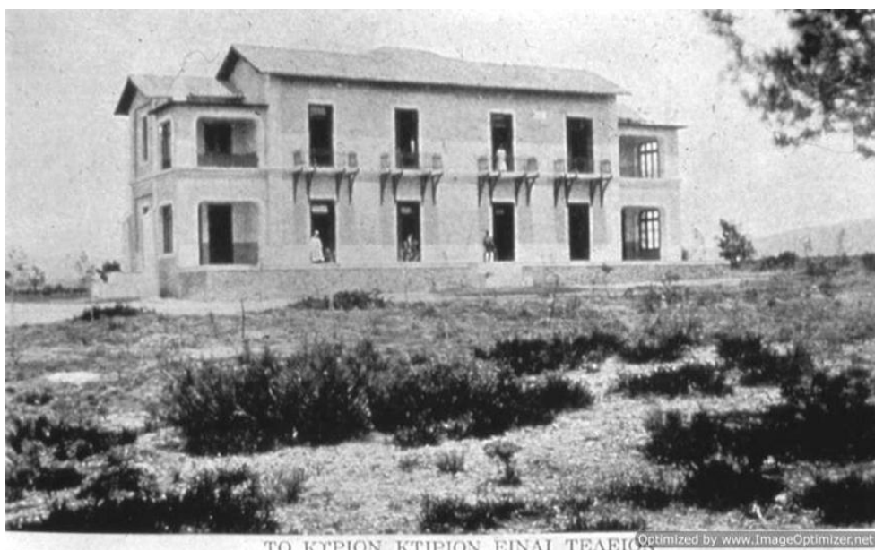
Εικόνα 2.1.2: Τα πρώτα περίπτερα της Σωτηρίας κατά τη φάση της ανοικοδόμησής τους (Πηγή: http://www.sotiria.gr/index.php?id=143 )
