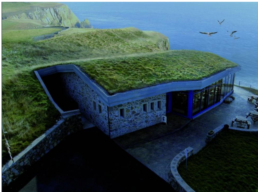
Εικόνα 6: Κεκλιμένο φυτεμένο δώμα εκτατικού τύπου σε περιοχή της Σκωτίας.
