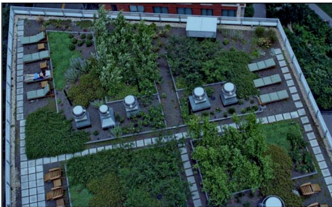
Εικόνα 2: Φυτεμένο δώμα πολυώροφου κτιρίου εντατικού τύπου (πηγή: media2.feed.gr/filesystem/images/2008504/eng )
