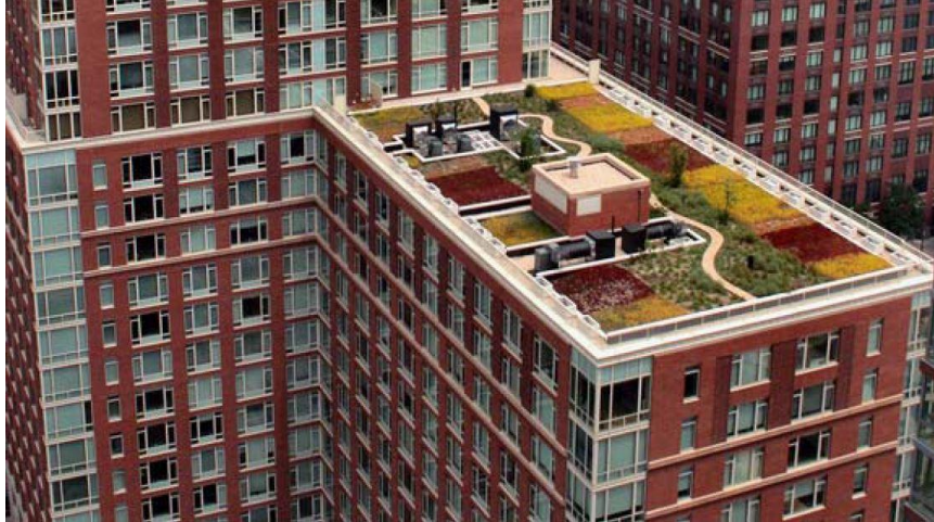
Εικόνα 5: Οριζόντιο φυτεμένο δώμα (πηγή: Χρηστίδου Βαγγελιώ - Βήτου Όλγα. Εργασία στα πλαίσια του μεταπτυχιακού μαθήματος Οικονομική Προσέγγιση στην Περιβαλλοντική Διαχείριση. Πανεπιστήμιο Αιγαίου Τμήμα Περιβάλλοντος Π.Μ.Σ. «Γεωργία & Περιβάλλον». Μυτιλήνη 2008.
