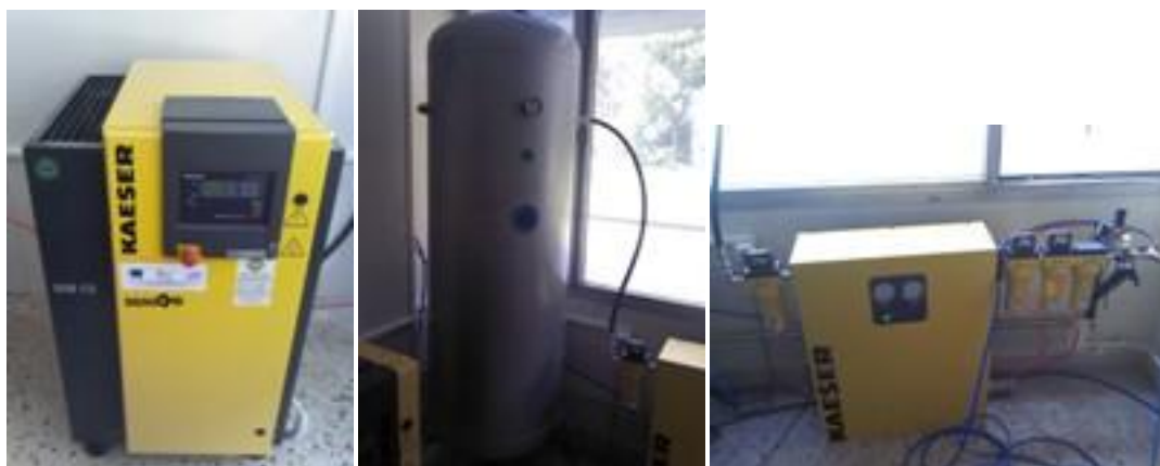
Σχήμα 3.2.1: Περιφερικά μηχανήματα Jet mil –συμπιεστήρας, φίλτρο και δεξαμενή αέρα (προσωπικό αρχείο).
