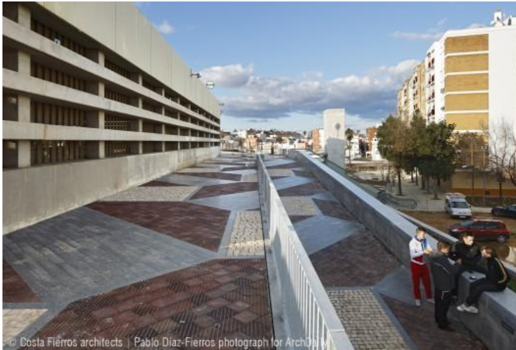
Εικόνα 13. Χαρακτηριστικά τοίχια αντιστήριξης. (Διαδικτυακή Πηγή 2: http://www.archdaily.com/232034/music-park-in-sevilla-costa-fierros-arquitectos/ )
