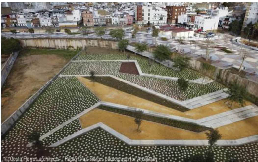
Εικόνα 12. Σχεδιαστική λεπτομέρεια με πλακόστρωτα. (Διαδικτυακή Πηγή 2 : http://www.archdaily.com/232034/music-park-in-sevilla-costa-fierros-arquitectos/ )
