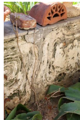
ΕΙΚΟΝΑ 143. Μερική άποψη ανατολικού κήπου του ξενοδοχείου «Δώμα». Διακρίνεται κατασκευαστική λεπτομέρεια, η οποία οριοθετεί διαδρόμο κίνησης μέσα στον χώρο του κήπου. Αποτελείται από τοιχίο ύψους 0.50m περίπου και από γλάστρες από πωρόλιθο, οι οποίες είναι στέρεα τοποθετημένες πάνω σε αυτόν. Οι γλάστρες αυτές τοποθετούνται πάνω στο τοιχίο ανά 1.50m περίπου (προσωπικό αρχείο, 2015).
