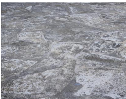
ΕΙΚΟΝΑ 197 και 198. Πλακόστρωση προκηπίου ξενοδοχείου «Δώμα». Χρήση ακανόνιστων πλακών από ασβεστόλιθο (προσωπικό αρχείο, 2015).
