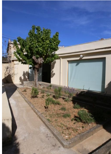
ΕΙΚΟΝΑ 208. Πλακόστρωση στη βόρεια όψη της οικίας Βενιζέλου. Παράδειγμα μεταγενέστερης εφαρμογής τσιμέντου (προσωπικό αρχείο, 2015).
