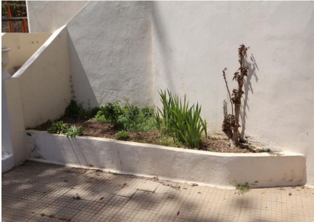
ΕΙΚΟΝΑ 206 και 207. Πλακόστρωση στο προκήπιο της οικίας Μαρκαντωνάκη. Δεξιά διακρίνεται λεπτομέρεια υλικού πλακόστρωσης από πλάκες τσιμέντου. Πρόκειται για μεταγενέστερη εφαρμογή (προσωπικό αρχείο, 2015).
