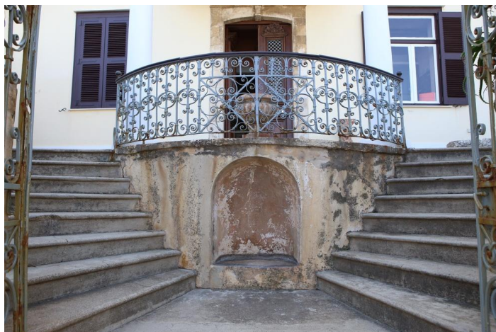
ΕΙΚΟΝΑ 173 και 174. Άποψη της σκάλας διπλής όψης στην είσοδο του προκηπίου στο ξενοδοχείο «Δώμα» με πρόσβαση επί της οδού Ελ. Βενιζέλου. Σκάλες ανόδου από το προκήπιο στο κτίριο στην είσοδο του προκηπίου του κτιρίου τοποθετημένες συμμετρικά εκατέρωθεν της κεντρικής εισόδου. Διακρίνεται και η κόγχη μετωπικά κάτω από το πλατύσκαλο. Ενδιαφέρον παρουσιάζει το ιδιαίτερο σχέδιο του κιγκλιδώματος (προσωπικό αρχείο, 2015).
