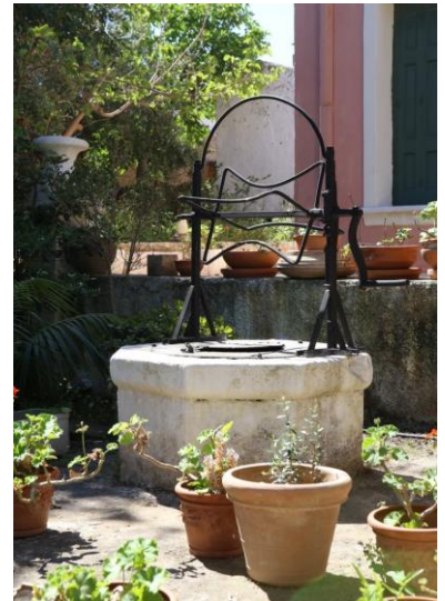
EIKONA 212 και 213. Υπόγεια στέρνα στην Βόρεια όψη και πρόσοψη οικίας Κυριάκου Μητσοτάκη ή «Γαλαρία», στον χώρο του προκηπίου. Δεξιά διακρίνεται η αντλία της υπόγειας στέρνας για την ανύψωση του νερού (σβίγα ή βίντσι) (προσωπικό αρχείο, 2015).
