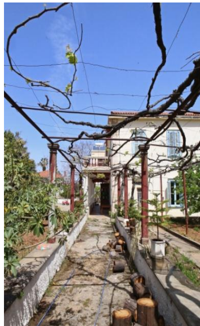
ΕΙΚΟΝΑ 210 και 211. Πέργολα για σκίαση στην οικία Μαρκαντωνάκη σχηματίζει διάδρομο περιπάτου σε συνέχεια με την στοά που σχηματίζει ο εξώστης. Η πέργολα στηρίζεται σε καλοσχηματισμένα κολωνάκια τετραγωνικής διατομής από μπετόν αρμέ ενώ πάνω σε αυτήν αναρριχάται μία Κληματαριά, Vitis vinifera (Vitaceae), η οποία στηρίζεται σε σιδερένιους δοκούς. Η κατασκευή της πέργολας χρονολογείται την δεύτερη δεκαετία του 20 ου αιώνα (προσωπικό αρχείο, 2015).
