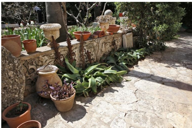
ΕΙΚΟΝΑ 143. Μερική άποψη ανατολικού κήπου του ξενοδοχείου «Δώμα». Διακρίνεται κατασκευαστική λεπτομέρεια, η οποία οριοθετεί διαδρόμο κίνησης μέσα στον χώρο του κήπου. Αποτελείται από τοιχίο ύψους 0.50m περίπου και από γλάστρες από πωρόλιθο, οι οποίες είναι στέρεα τοποθετημένες πάνω σε αυτόν. Οι γλάστρες αυτές τοποθετούνται πάνω στο τοιχίο ανά 1.50m περίπου (προσωπικό αρχείο, 2015).
