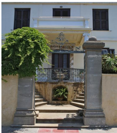
ΕΙΚΟΝΑ 173 και 174. Άποψη της σκάλας διπλής όψης στην είσοδο του προκηπίου στο ξενοδοχείο «Δώμα» με πρόσβαση επί της οδού Ελ. Βενιζέλου. Σκάλες ανόδου από το προκήπιο στο κτίριο στην είσοδο του προκηπίου του κτιρίου τοποθετημένες συμμετρικά εκατέρωθεν της κεντρικής εισόδου. Διακρίνεται και η κόγχη μετωπικά κάτω από το πλατύσκαλο. Ενδιαφέρον παρουσιάζει το ιδιαίτερο σχέδιο του κιγκλιδώματος (προσωπικό αρχείο, 2015).
