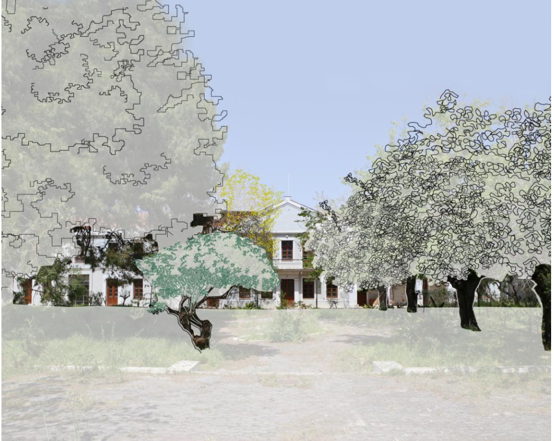
ΕΙΚΟΝΑ 97. Πρόσωση κτιρίου Γαλλικής Σχολής Καλογραιών, σήμερα. Παρατηρείται η εξέλιξη των προγενέστερων φυτεύσεων, οι οποίες καλύπτουν την πρόσωση του κτιρίου και ότι έχει διαφοροποιηθεί η σχέση φυτικού υλικού και κτιρίου σήμερα (προσωπικό αρχείο, 2015).
