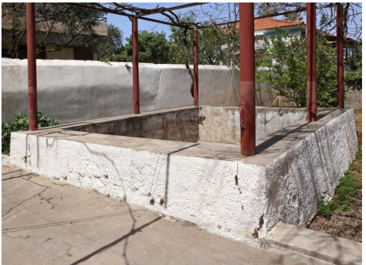
ΕΙΚΟΝΑ 215. Υπόγεια θολωτή στέρνα για την συλλογή του νερού από την στέγη στην νότια όψη της οικίας Θεμιστοκλή Μητσotάκη (προσωπικό αρχείο, 2015).
