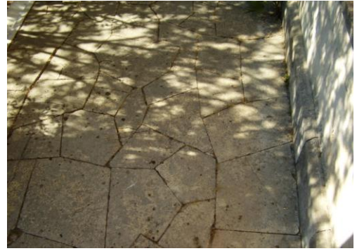
ΕΙΚΟΝΑ 193 και 194. Πλακόστρωση γύρω από το κτίριο του Ι.Ν. Αγίας Μαγδαληνής πριν την ανάπλαση του 2008. Ακανόνιστες πλάκες από ασβεστόλιθο ως υλικό πλακόστρωσης περιβάλλουν τον ναό (πηγή: Τσουκάτος, 2007).
