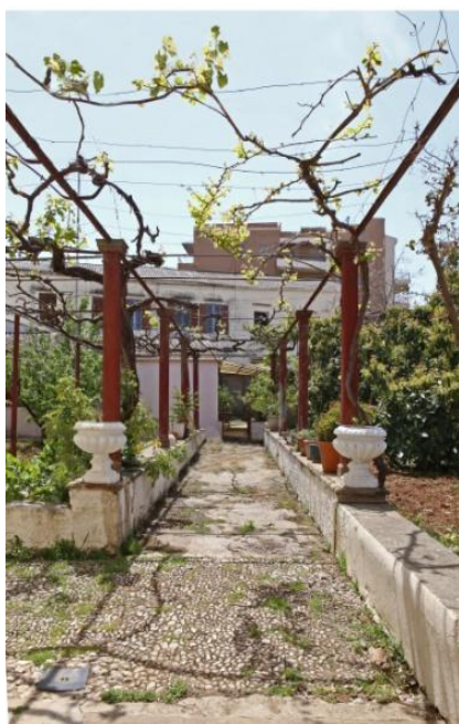
ΕΙΚΟΝΑ 210 και 211. Πέργολα για σκίαση στην οικία Μαρκαντωνάκη σχηματίζει διάδρομο περιπάτου σε συνέχεια με την στοά που σχηματίζει ο εξώστης. Η πέργολα στηρίζεται σε καλοσχηματισμένα κολωνάκια τετραγωνικής διατομής από μπετόν αρμέ ενώ πάνω σε αυτήν αναρριχάται μία Κληματαριά, Vitis vinifera (Vitaceae), η οποία στηρίζεται σε σιδερένιους δοκούς. Η κατασκευή της πέργολας χρονολογείται την δεύτερη δεκαετία του 20 ου αιώνα (προσωπικό αρχείο, 2015).
