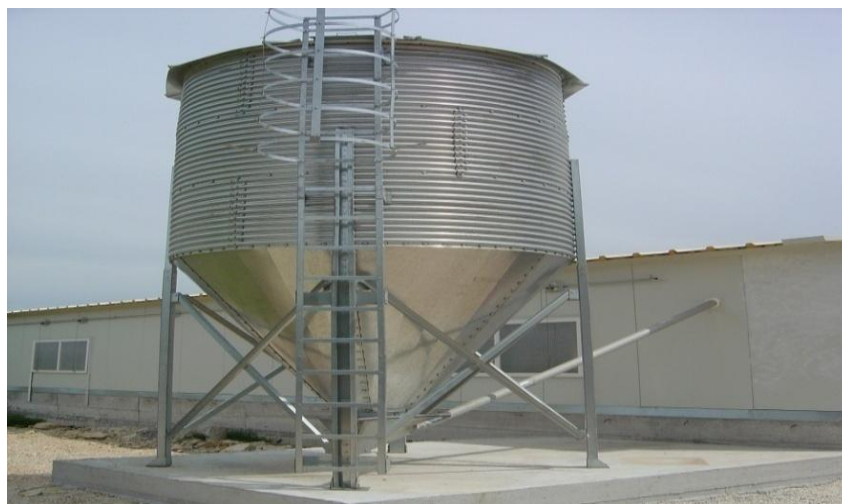
Εικόνα 1.8: Σιλό έτοιμου μείγματος
