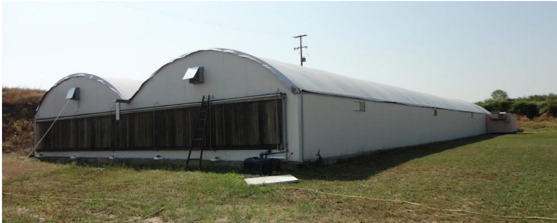
Εικόνα 1.5.4: Μονάδα εκτροφής μεταξοσκώληκα τύπου «Τολλ» με σύστημα δροσίσιμou.
