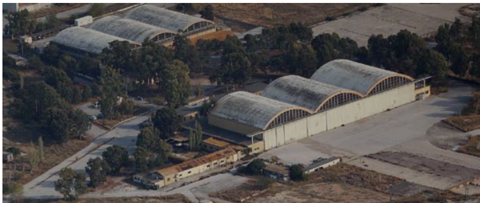
Εικ. 31: Διατηρητέα κτήρια, πρώην υπόστεγα αεροπλάνων Πηγή: Δ14
