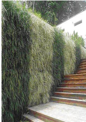
Εικόνα 5: «Ζωντανός τοίχος με ενότητες» χωρίς και με υπόστρωμα & φυτικό υλικό.
