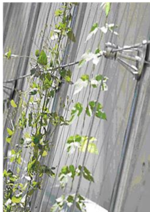
Εικόνα 2 (Αριστερά: Πράσινη πρόσοψη τύπου “Modular trellis panel system”, Δεξιά: Πράσινη πρόσοψη τύπου “Cable wire – rope net system”(Δ4).
