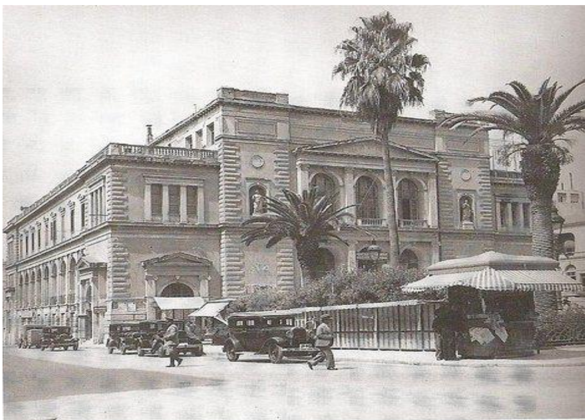
Εικ. 8: Δεκαετία 1930, Δημοτικό Θέατρο (νυν πλατεία Κοτζιά) κατεδαφίστηκε το 1938 (Διαδ. 24)
