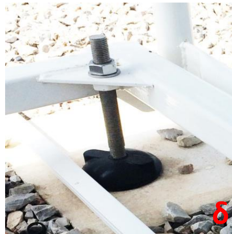
Εικόνα 3.3. α) Θερμομόνωση με πλάκες εξηλλαγμένης πολυστερίνης πάχους 5 cm στο δάπεδο και στις πλευρές του λυσιμέτρου, β) Εγκατάσταση μεμβράνης στεγανοποίησης γ) Θερμομονωμένο και υδρομονωμένο λυσίμετρο στην οριστική του θέση δ) Λεπτομέρεια έδρασης της βάσης των λυσιμέτρων
