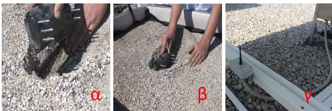
Εικόνα 3.12. α, β) Τοποθέτηση ασύρματων αισθητήρων μέσα στο υπόστρωμα των λυσιμέτρων.
