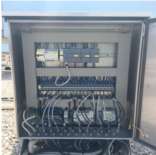
Εικόνα 3.5. Το PLC καταγραφής του ρυθμού απορροής των λυσιμέτρων το οποίο κατέγραφε και αναμετάδιδε τα δεδομένα των ογκομετρητών μέσω διαδικτύου
