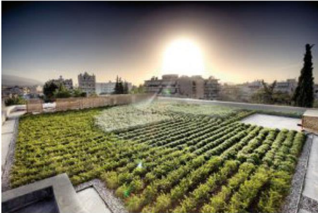
Εικόνα 1.8. Φυτοδώμα Ημιεντατικού τύπου στο Carrefour στο Χαλάνδρι. (Πηγή: https://www.google.gr/search?q=Carrefour,+Χαλάνδρι&rlz ).
