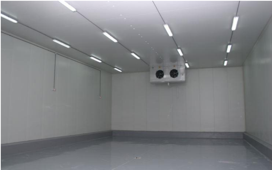
Εικόνα 2.2.1. Εσωτερικό ψυκτικού θαλάμου (πηγή: Alfa Cool Hellas)
