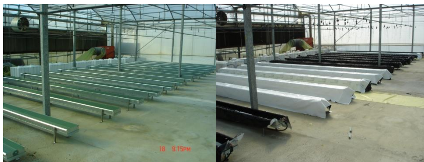
Εικόνα 3.3. Παράλληλα τοποθετημένα μεταλλικά κανάλια (υδρορροές) τύπου NFT επενδυμένα από μαλακό φύλλο PE μαύρο εσωτερικά και λευκό εξωτερικά.
