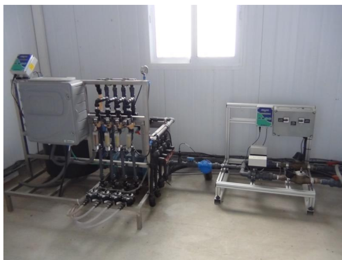
Εικόνα 2.2. Κεφαλή υδρολίπανσης και σύστημα ανάμειξης διαλύματος απορροής και νερού σε ρυθμιζόμενη αναλογία με βάση μια προεπιλεγμένη τιμή EC_t .
