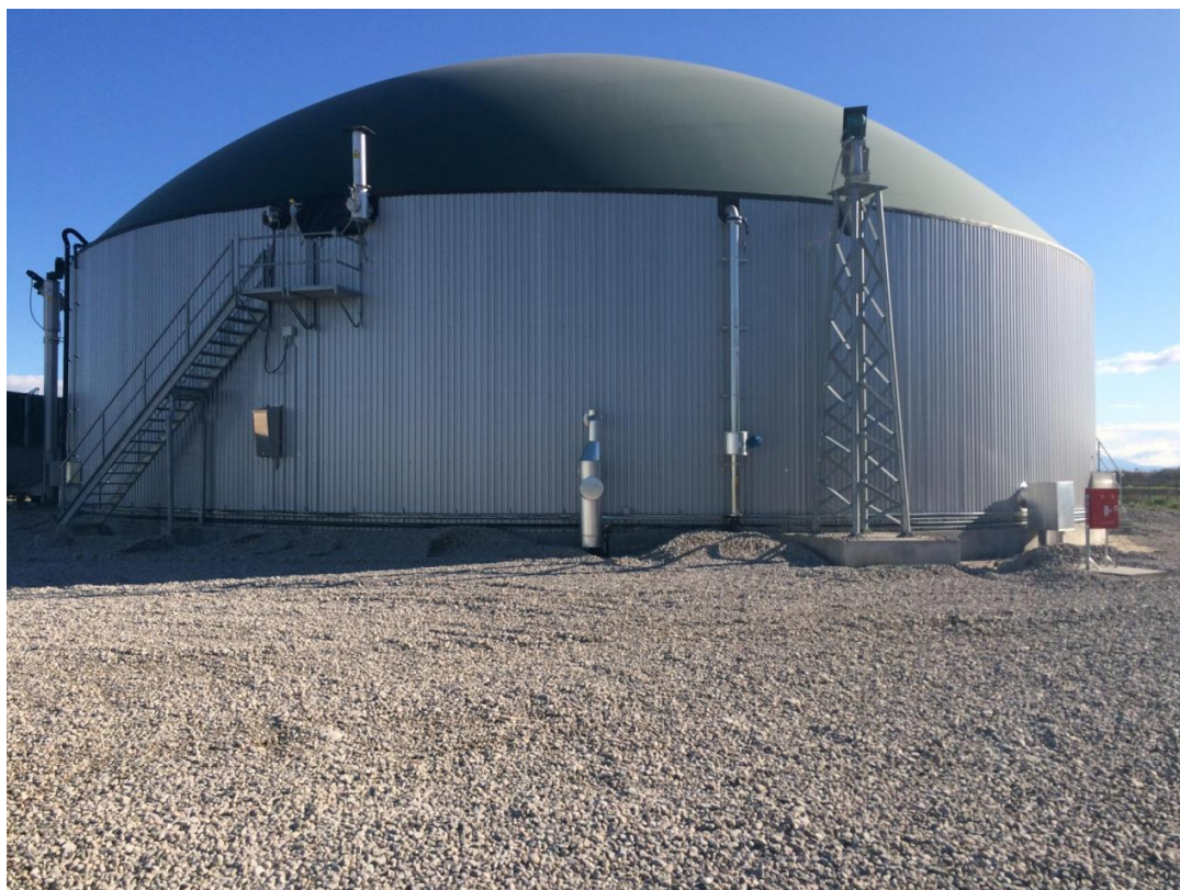
Εικόνα 6.5.1 ΕΞΩΤΕΡΙΚΗ ΟΨΗ ΕΡΓΟΣΤΑΣΙΟΥ.
