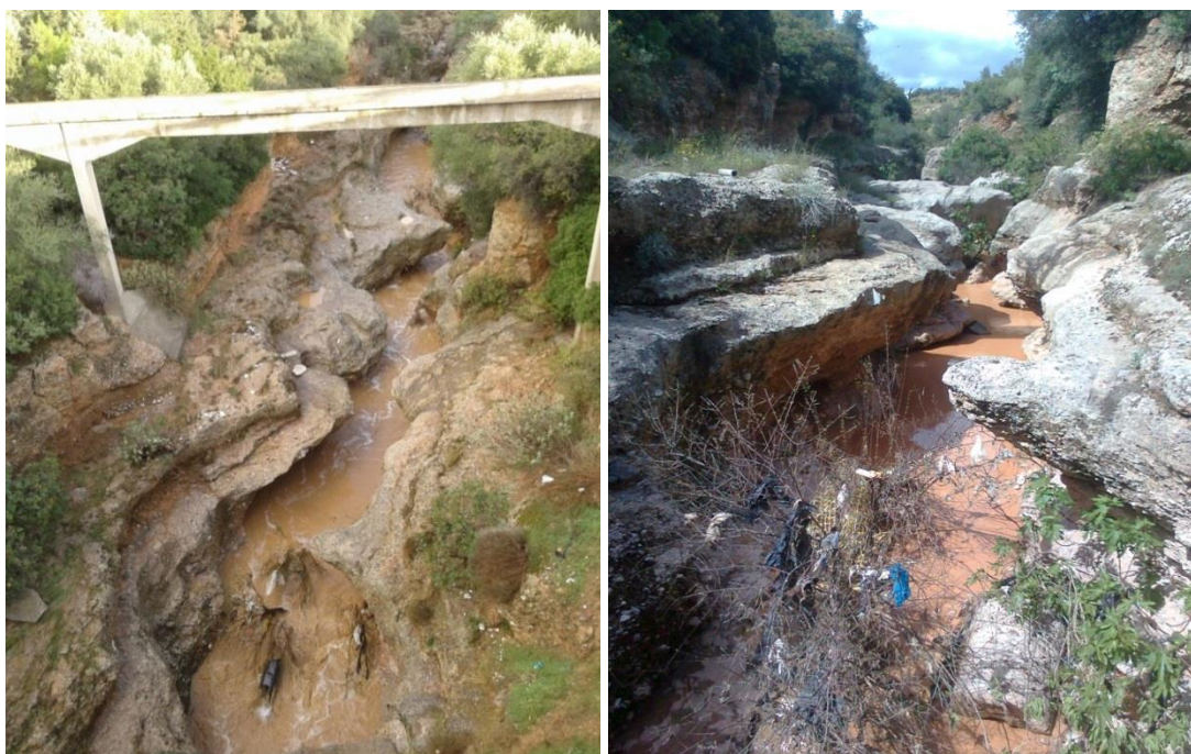
Εικόνα 5.2: Κατά βάθος διάβρωση στο ρ. Σαρανταπόταμου.
