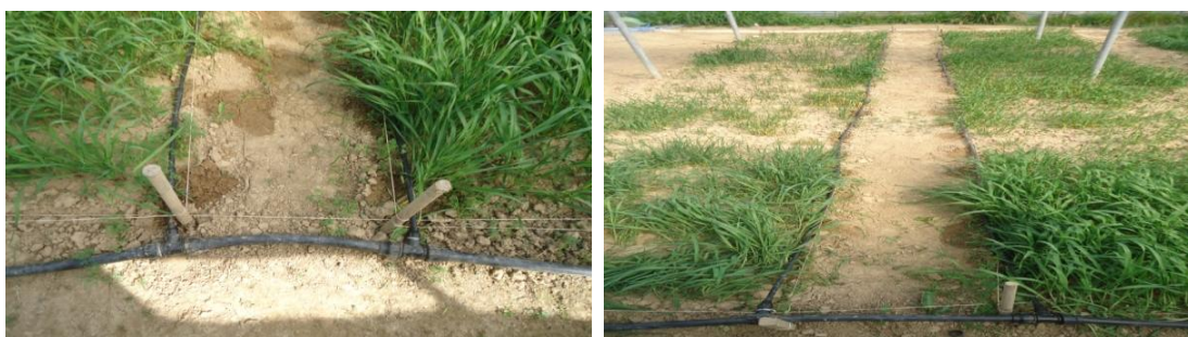
Εικόνες 2.3.2 a & b. Εγκατάσταση του αρδευτικού συστήματος.
