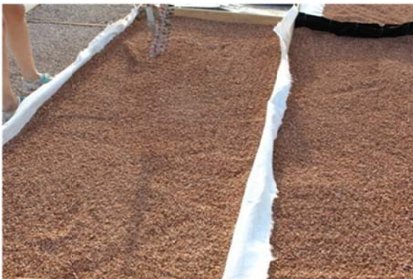
Εικόνα 60: Το τελικό αποτέλεσμα, διακρίνεται η τελευταία στρώση της διάταξης, η ψηφίδα
