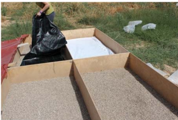
Εικόνα 54: Η πρώτη στρώση γεωφάσματος πάνω από τη χαλαζιακή άμμο, διακρίνονται οι δύο τύποι γεωφάσματος άσπρο: μη υφαντό, μαύρο: υφαντό
