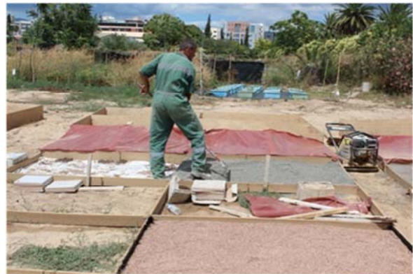
Εικόνα 68: Ισοπέδωση του Sand πριν από τη συμπίεση
