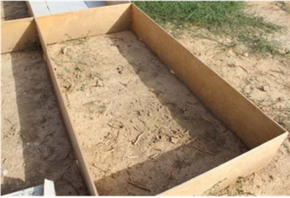
Εικόνα 50: Τα ξύλινα καλούπια στα οποία εγκιβωτίστηκαν οι πειραματικές διατάξεις κατάχωσης
