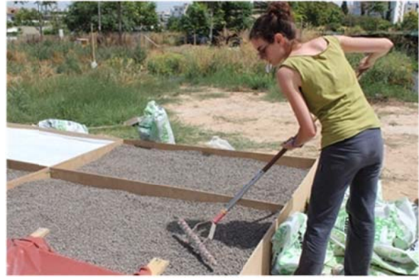
Εικόνα 57: Ισοπέδωση της στρώσης του LECA
