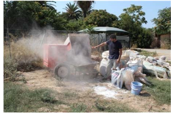
Εικόνα 72: Η μεταφορά του ξηρού μίγματος για το κονίαμα ΜΤ προς τα καλούπια
