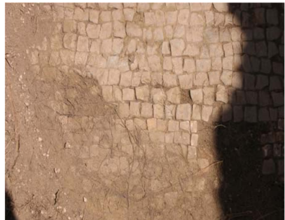
Εικόνα 18: Ανάπτυξη ριζικού συστήματος σε ψηφιδωτό δάπεδο (προσωπικό αρχείο λήψη 2006)
