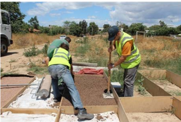
Εικόνα 65: Συμπίεση του Hydromedia με κόπανο
