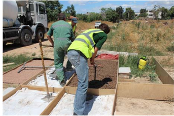
Εικόνα 64: Ισοπέδωση του Hydromedia πριν τη συμπίεση
