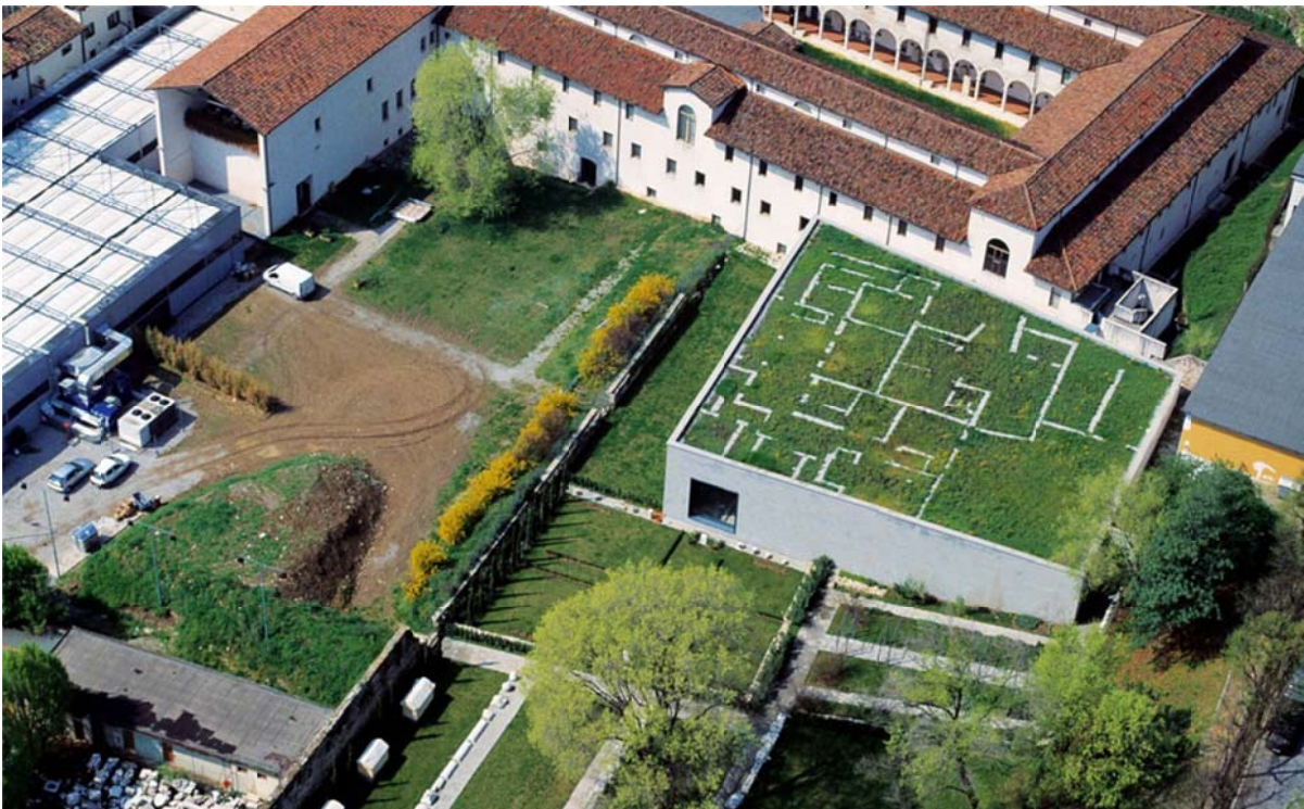
Εικόνα 118: Πανοραμική άποψη του προστατευτικού κελυφους που χτίστηκε πάνω από τα ερείπια Ρωμαϊκών οικιών στη Brescia. Στη στέγη διακρίνεται η απόδοση της κάτοψης των ερειπίων με σκληρά υλικά και η κάλυψη με χλοοτάπητα ( divisare.com , 2016)
