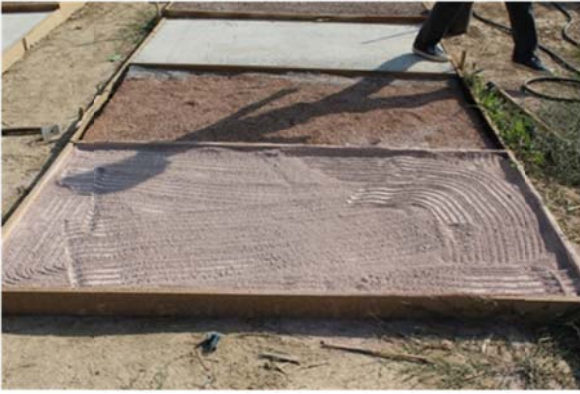
Εικόνα 75: Ομοιόμορφη κατανομή του ξηρού μίγματος για το κονίαμα Μ7 στα καλούπια και ισοπέδωση
