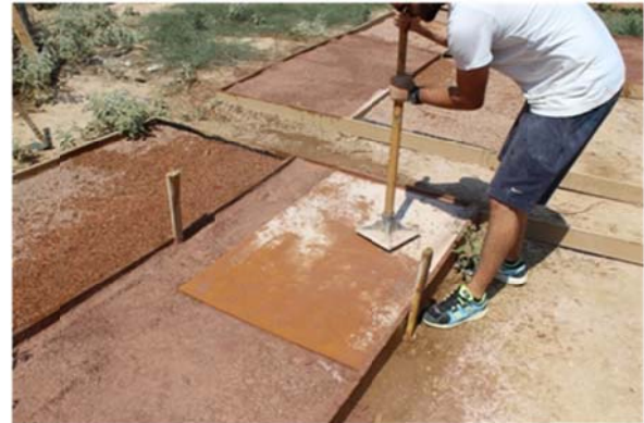
Εικόνα 78: Συμπύεση του κονιάματος Μ7 μετά τη διαβροχή με χειροκίνητο κόπανο
