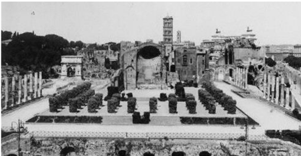
Εικόνα 106: Ο Ναός της Αφροδίτης και Ρώμης μετά την αποκατάσταση του Μυΐοζ, 1934-35. Διακρίνεται η υποδήλωση ελλειπόντων αρχιτεκτονικών στοιχείων με φυτικά είδη (beniculturali.it, 2017)
