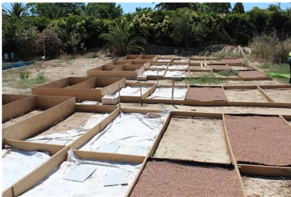
Εικόνα 61: Τα ξύλινα πλαίσια (καλούπια) στα οποία εγκιβωτίστηκαν τα υλικά, διακρίνεται το λευκό γεωύφασμα που τοποθετήθηκε πριν τη χύτευση
