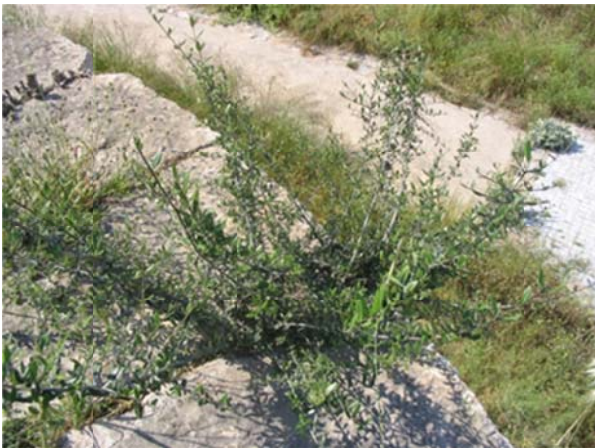
Εικόνα 11: Ανάπτυξη δενδρυλλίου ελιάς στο διάκενο μεταξύ δομικών λίθων οχυρωματικού τείχους στην Ελευσίνα (προσωπικό αρχείο, λήψη 2006)
