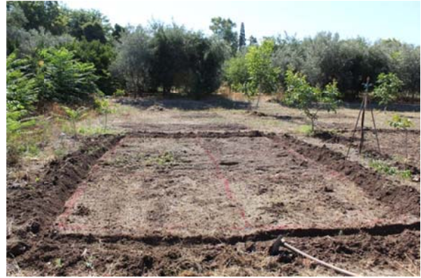
Εικόνα 46: Η διάνοιξη αυλακιού περιφερικά των τεμαχίων για την παράχωση του φύλλου πλαστικού
