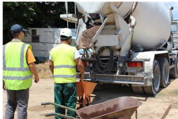
Εικόνα 62: Μεταφορά του σκυροδέματος Hydromedia από τη μπετονιέρα προς τα καλούπια
