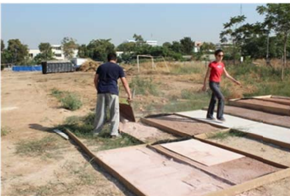
Εικόνα 73: Η χύτευση του ξηρού μίγματος για το κονίαμα ΜΤ στα καλούπια
