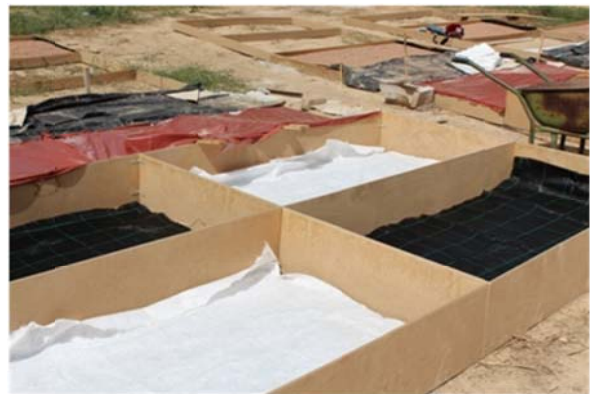
Εικόνα 55: Η πρώτη στρώση γεωφάσματος, διακρίνονται οι δύο τύποι, άσπρο: μη υφαντό, μαύρο: υφαντό
