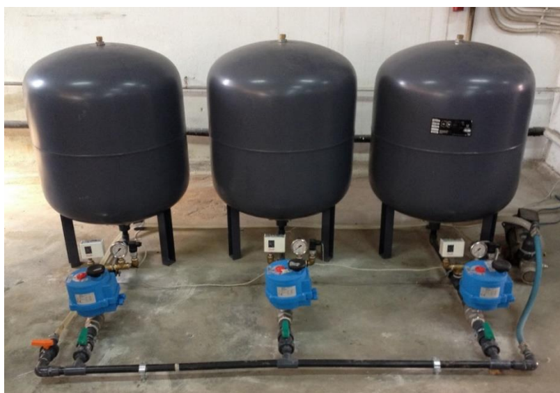
Εικόνα 7-11 Σύστοιχία πιεστικών δοχείων
