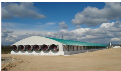
Εικόνα 15: Κτίριο κατασκευής για πτηνοτροφείο
