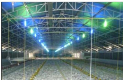
Εικόνα 23: Εσωτερικό θαλάμου και φωτισμός
