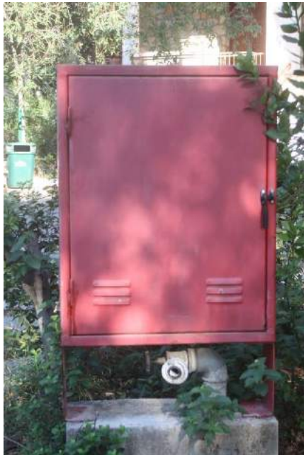
Εικόνα 61. Πυροσβεστικός κρουνός.
