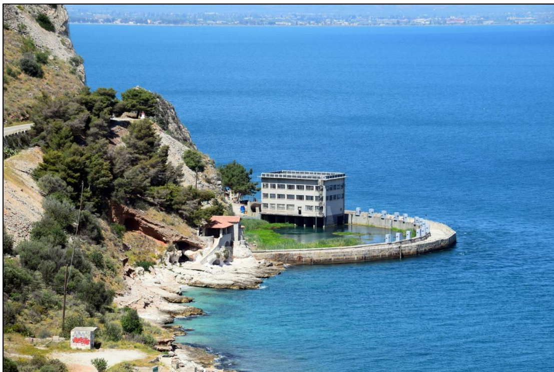
Εικόνα 4.1: Το φράγμα του συλλογής ποσότητας νερού από την υποθαλάσσια πηγή του Αναβάλου στο Κιβέρι Αργολίδας ( Wikipedia , 2017).
