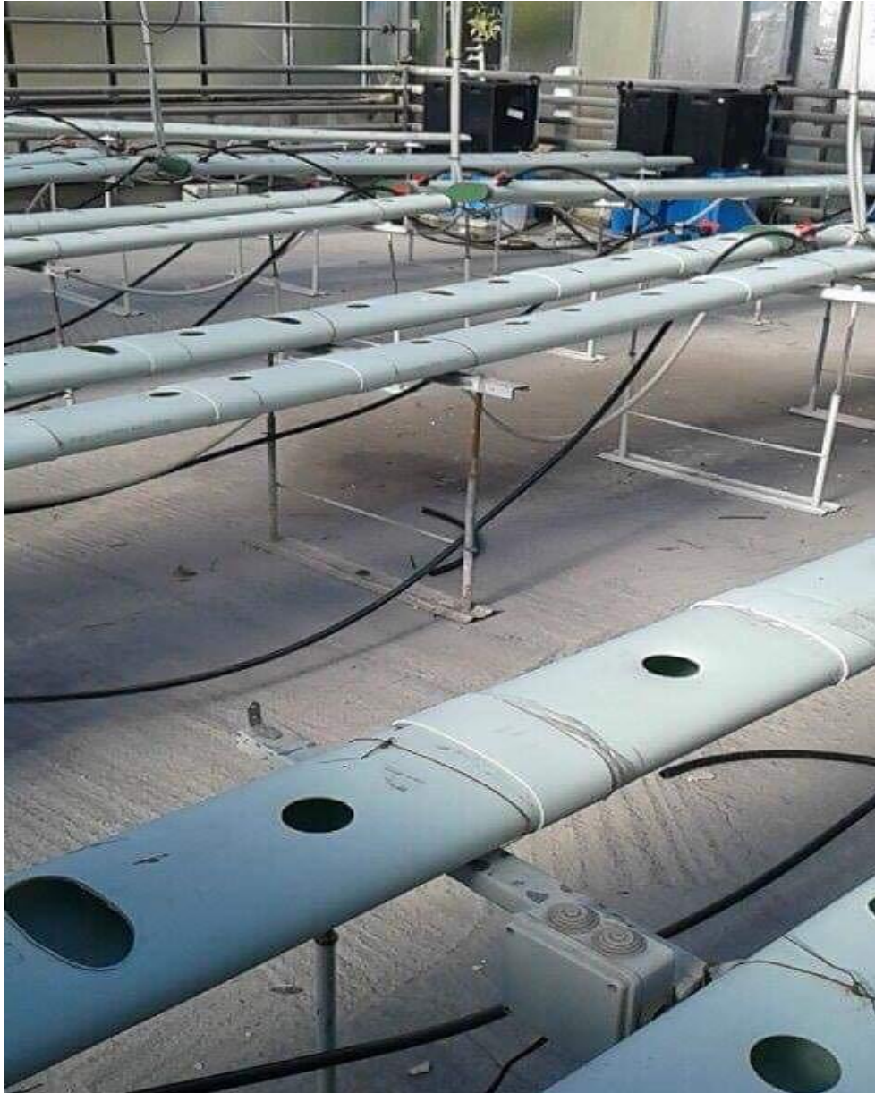
Εικόνα : Κανάλια PVC στηριγμένα σε σιδερένιο σκελετό.
