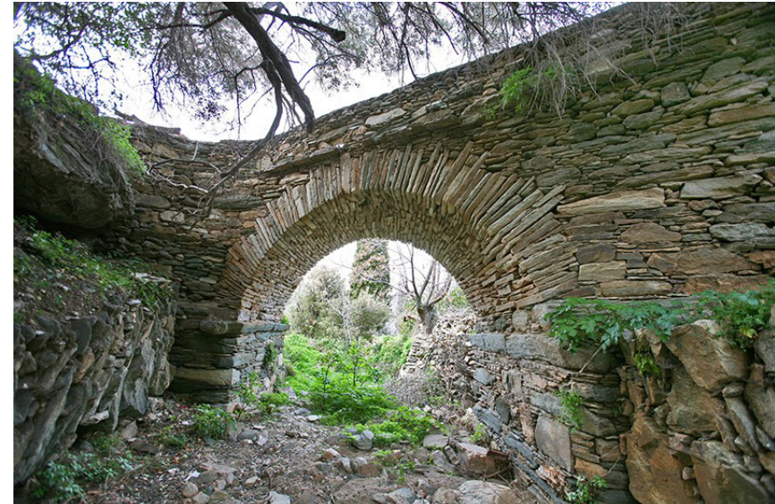
Εικόνα 26_Λοξό γεφύρι-Αηδόνια, Πηγή: Google.gr
