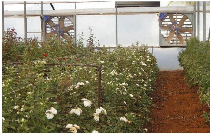
Εικόνα 17: Δροσισμός θερμοκηπίου με συστήματα ανεμιστήρων εξαγωγής αέρα (πηγή: mo.gov.sy)
