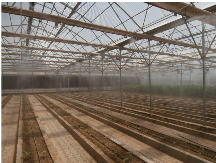
Εικόνα 18: Δροσισμός θερμοκηπίου με υδρονέφωση (πηγή: hortitech)
