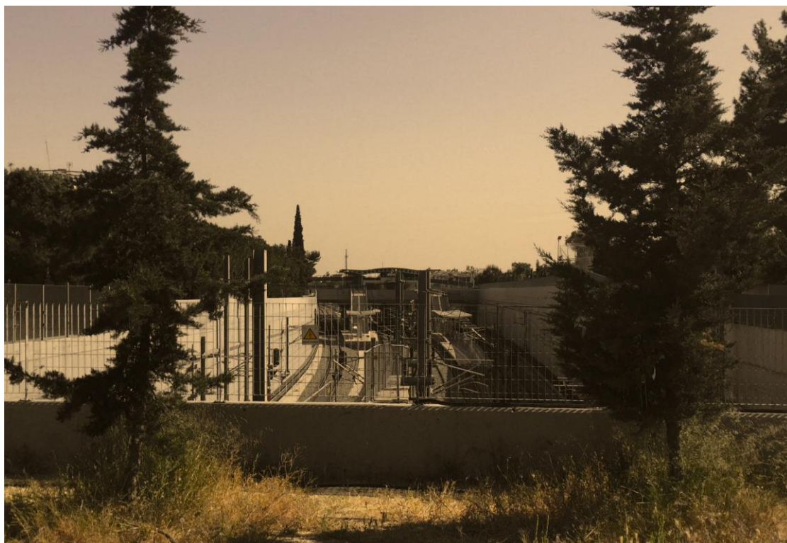
Εικόνα 9: Τμήμα του υπογειοποιημένου σιδηροδρομικού σταθμού στο σταθμό Αγ. Αναργύρων Πηγή: Προσωπικό αρχείο
