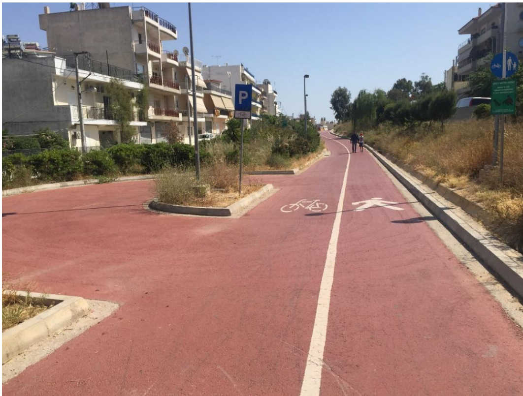
Εικόνα 11: Ποδηλατοδρόμος στο Πάρκο του ανισοπεδοποιημένου σιδηροδρομικού διαδρόμου από την αρχή του σταθμού Αγ. Αναργύρων έως το σταθμό Πύργου Βασιλίσσης. Πηγή: Προσωπικό αρχείο
