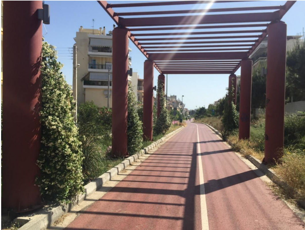
Εικόνα 10: Πέργκολα μεταλλικής κατασκευής στο Πάρκο του ανισοπεδοποιημένου σιδηροδρομικού διαδρόμου από την αρχή του σταθμού Αγ. Αναργύρων έως το σταθμό Πύργου Βασιλίσσης. Πηγή: Προσωπικό αρχείο
