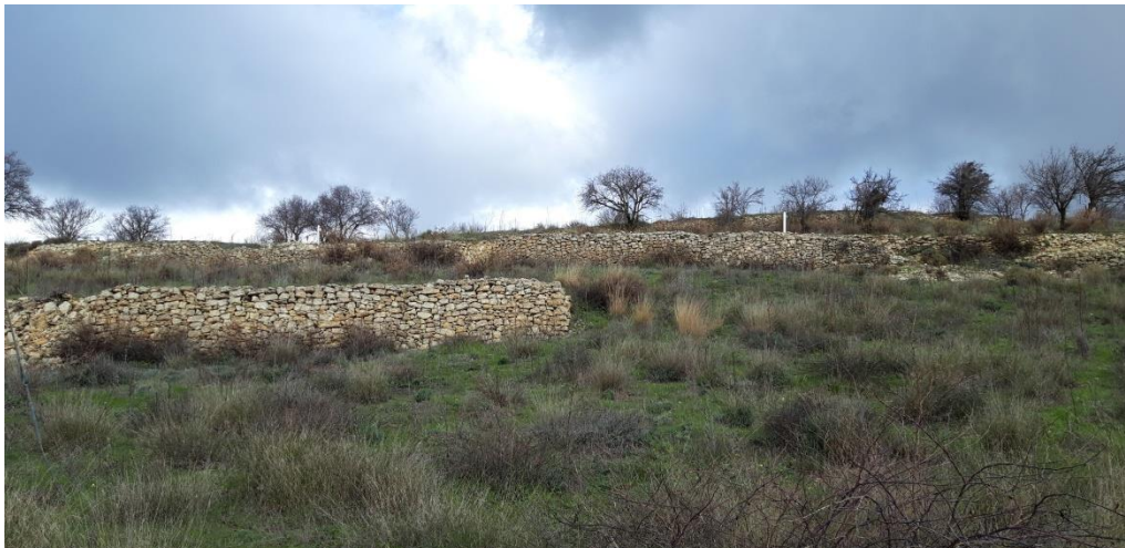
Εικόνα 106: Ξερολιθικοί τοίχοι στο δρόμο Βάσας - Ομόδους (Πηγή: Προσωπικό αρχείο)
