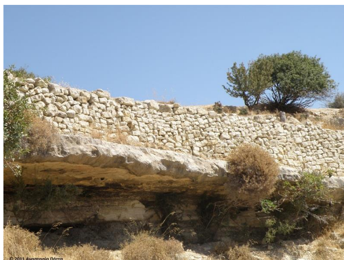
Εικόνα 20: Τοίχος αντιστήριξης από ξερολιθιά στο χωριό Άγιος Θεράπων της επαρχίας Λεμεσού (Πηγή:Θεοδοσίου, 2015)
