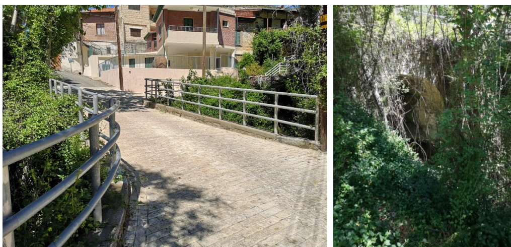
Εικόνα 142: Η γέφυρα που βρίσκεται εντός του χωριού (Πηγή: Προσωπικό αρχείο)
