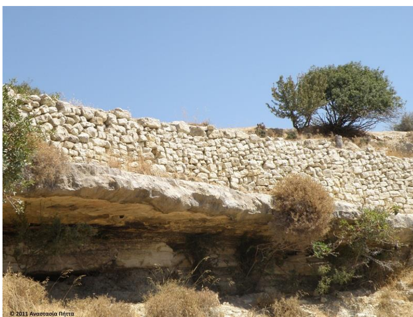
Εικόνα 18: Τοίχος αντιστήριξης από ξερολιθιά στο χωριό Άγιος Θεράπων (Πηγή: Θεοδοσίου, 2015)
