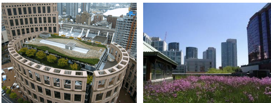
Εικόνα 7. Φυτεμένα δώματα σε δημόσια κτίρια και εμπορικά κέντρα του Καναδά προσφέρουν όμορφη θέα στους κατοίκους και τους εργαζόμενους των γύρω κτιρίων (Αριστερά: Vancouver Public Library Green Roof, Δεξιά: Mountain Equipment Co-op Green Roof, Δ2).
