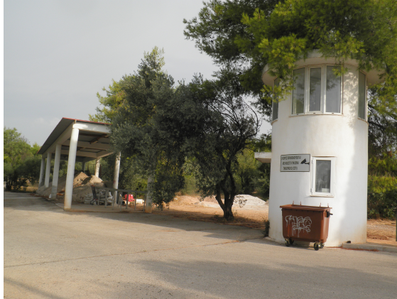
Εικόνα 37: Φυλάκιο και υπόστεγο για τη στάθμευση στρατιωτικών οχημάτων στην συμβολή των οδών Καλλιανίου και Φιλικής Εταιρείας (Πηγή: προσωπικό αρχείο)
