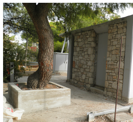
Εικόνα 43: Οι χώροι υγιεινής (Πηγή: προσωπικό αρχείο)
