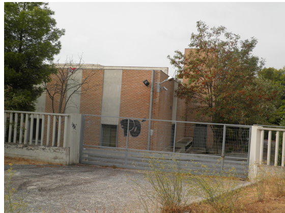
Εικόνα 39: Το κτήριο που στεγάζει τον υποσταθμό της Δ.Ε.Η. (Πηγή: προσωπικό αρχείο)
