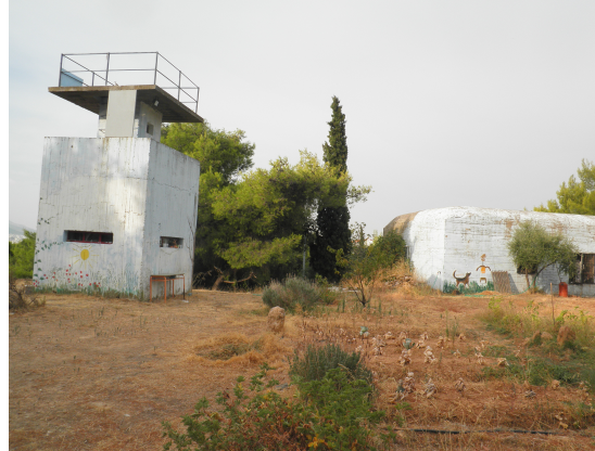
Εικόνα 38: Φυλάκιο και κτίσμα μηχανολογικού εξοπλισμού πάνω στον λόφο που καλύπτει το ναυτικό οχυρό (Πηγή: προσωπικό αρχείο)
