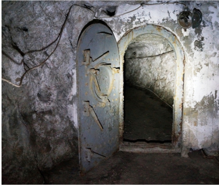
Εικόνα 10: Η θύρα που έχει χρησιμοποιηθεί προέρχεται από παροπλισμένο θωρηκτό (Πηγή: Δ9)
