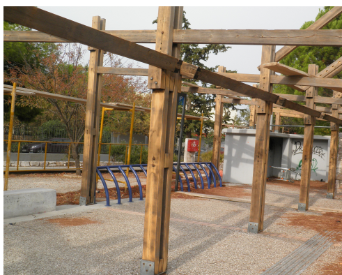
Εικόνα 42: Το πέτρινο ασκεπές κτίσμα με την πέργκολα δίπλα στη λίμνη (Πηγή: προσωπικό αρχείο)
