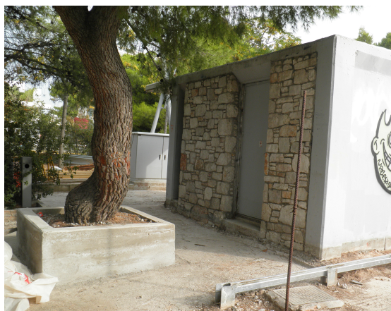
Εικόνα 54: Ο υπάρχων χώρος υγιεινής διατηρείται σε καλή κατάσταση (Πηγή: Προσωπικό αρχείο)
