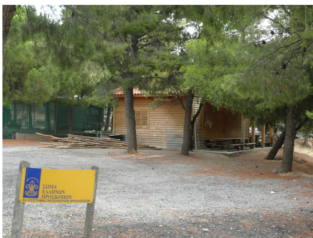
Εικόνα 77: Το κτήριο των προσκόπων ανάμεσα στα πεύκα (Πηγή: Προσωπικό αρχείο)
