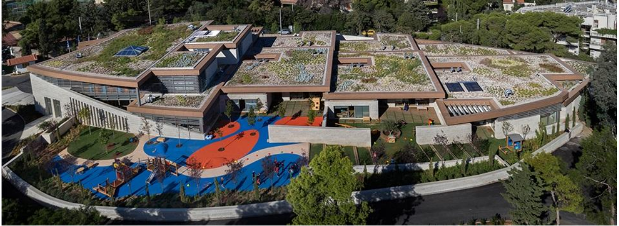
Εικόνα 4: Φυτοδώματα εγκατεστημένα στην οροφή του νηπιαγωγείου “Ιωάννης Μ. Καρράς” στην Ελλάδα.
